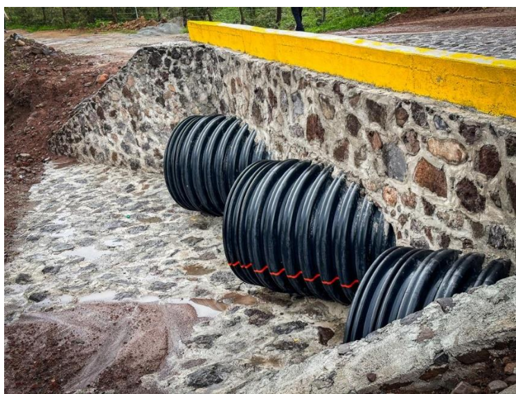
Figura II.9 forma ilustrativa de zampeado
