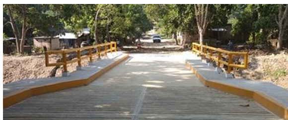
Figura II. 10 imagen ilustrativa de banqueta peatonal.
