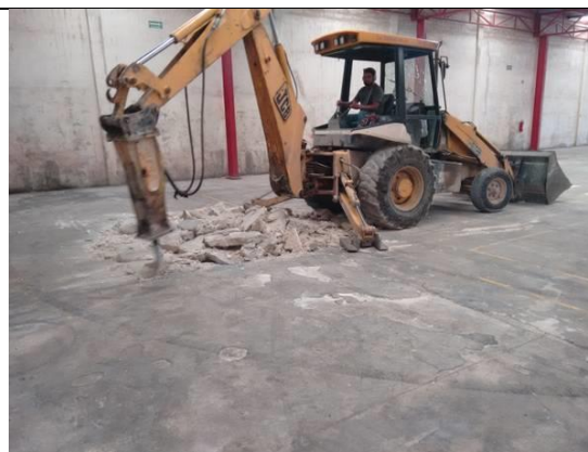
Imagen ilustrativa de demolición de concreto con maquinaria.
