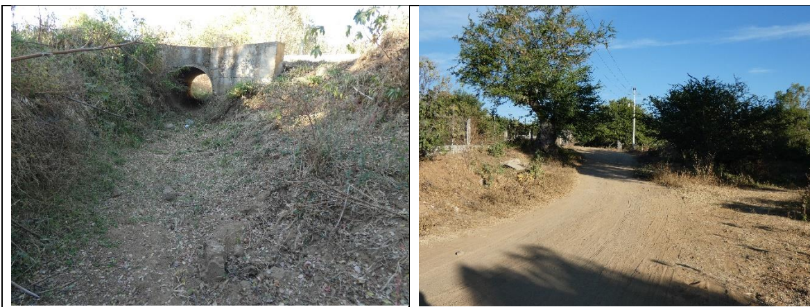
Figura II.12 obra que se ubica en las coordenadas: X: 735992.94 y Y: 1877526.98 donde el cauce es menor a 5.00 metros (nótese que solo se implementa un tubo)
