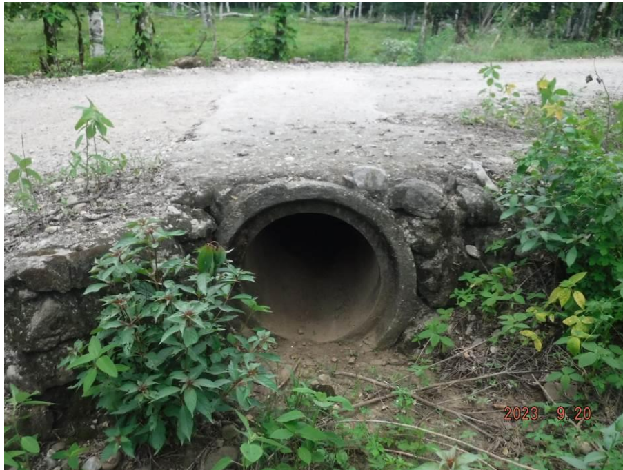
Figura II. 10. Obras de alcantarilla en el km 3+460 del camino.
