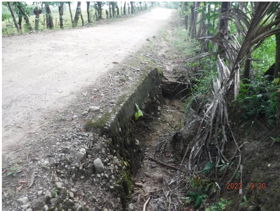
Figura II. 9. Obras de alcantarilla en el km 2+280 del camino.
