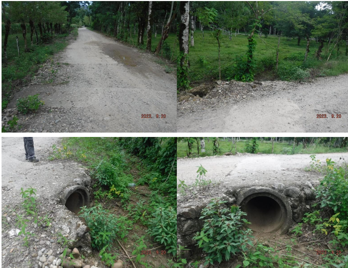
Foto 37 a la 40: Condiciones actuales del km 3+460, los usos de sus colindancias, alcantarillado pluvial.
