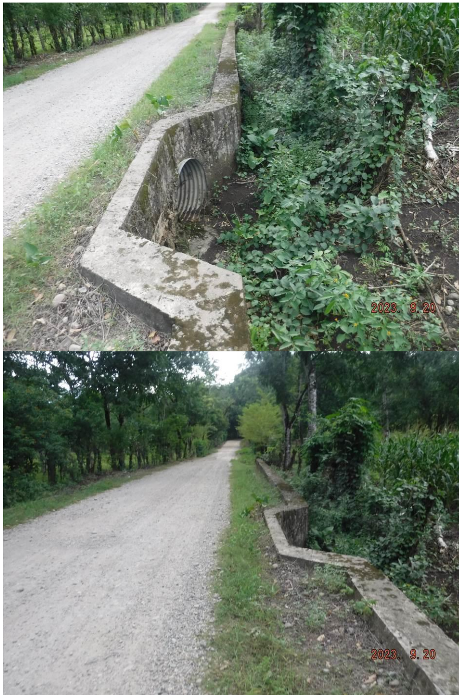
Figura II. 12 y Figura II. 13. Obras de alcantarilla en el km 4+100 y 4+140 del camino.
