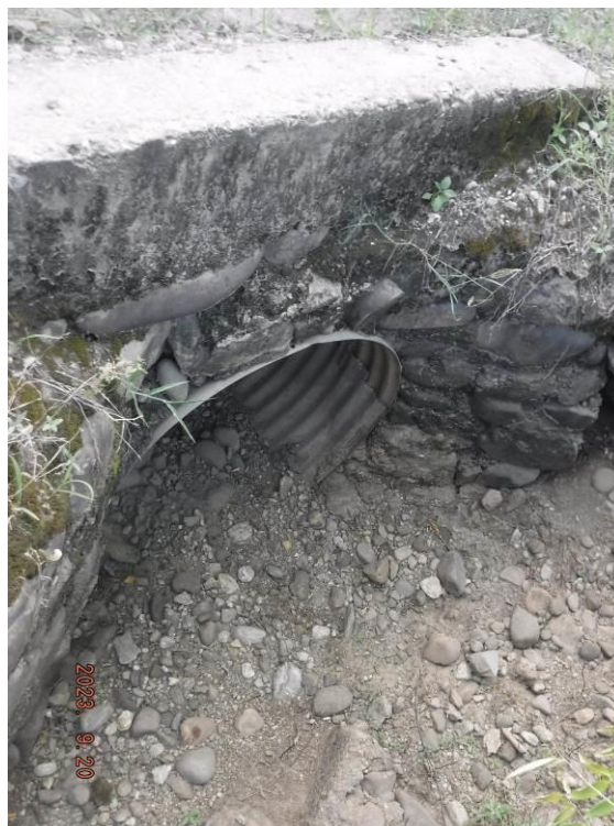
Figura II. 15. Obras de alcantarilla en el km 5+680 del camino.
