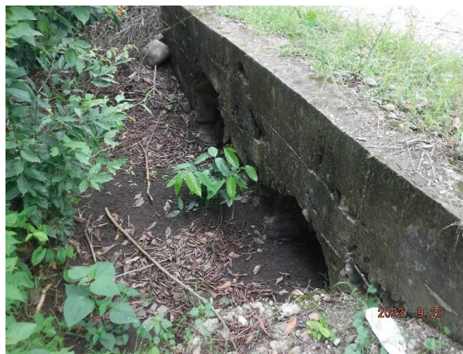
Foto 69 a la 71: Condiciones actuales del km 4+800, los usos de sus colindancias, Alcantarillado pluvial.
