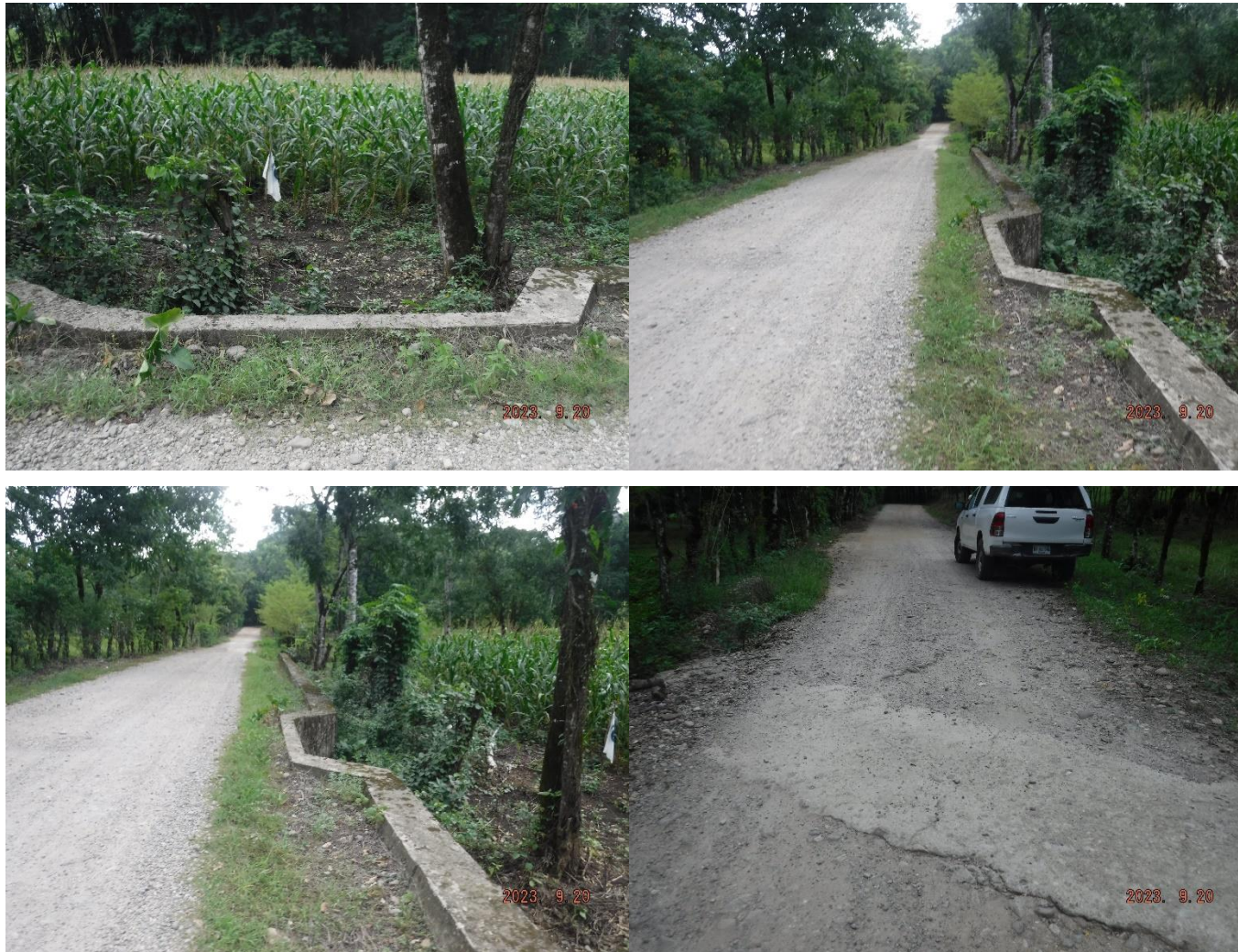
Foto 57 a la 60: Condiciones actuales del km 4+140, los usos de sus colindancias, alcantarillado pluvial.
