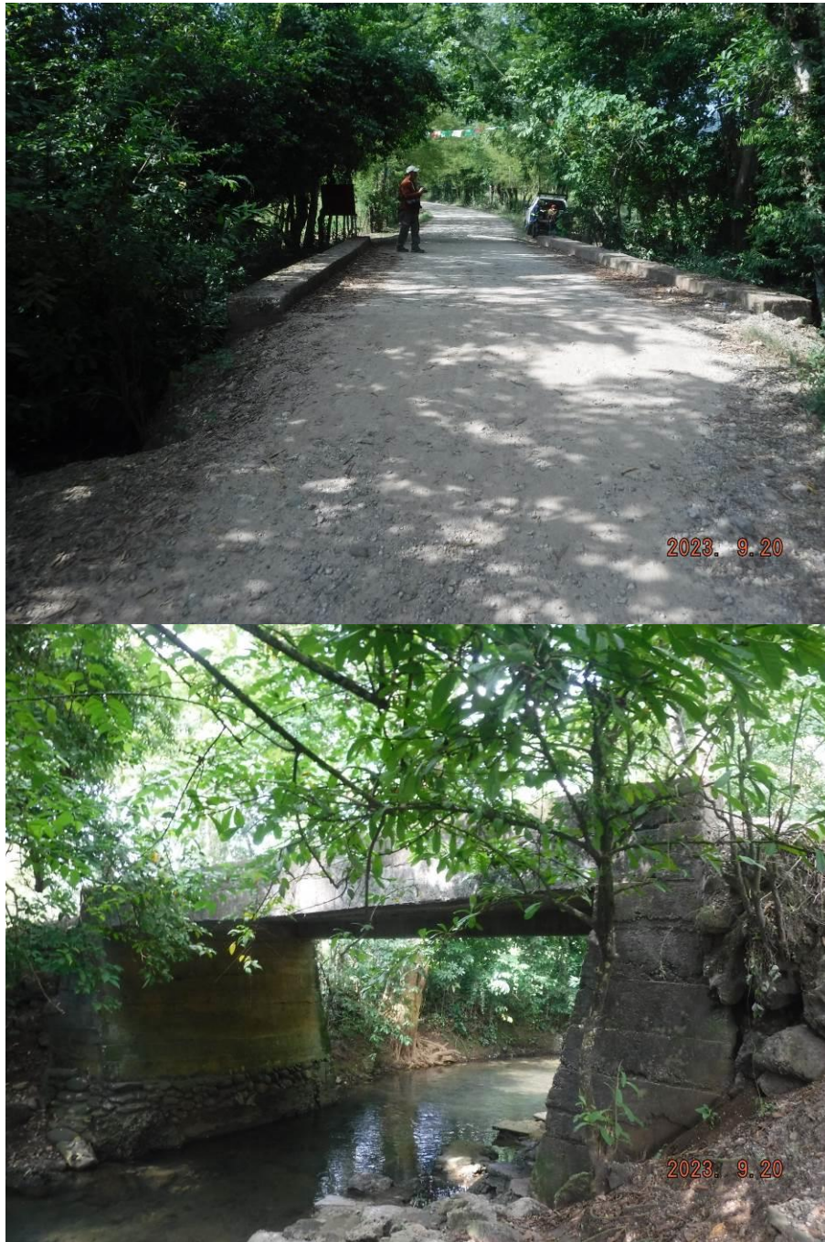
Figura II. 16 y Figura II. 17. Puente y río permanente a la altura del Km 5+980
