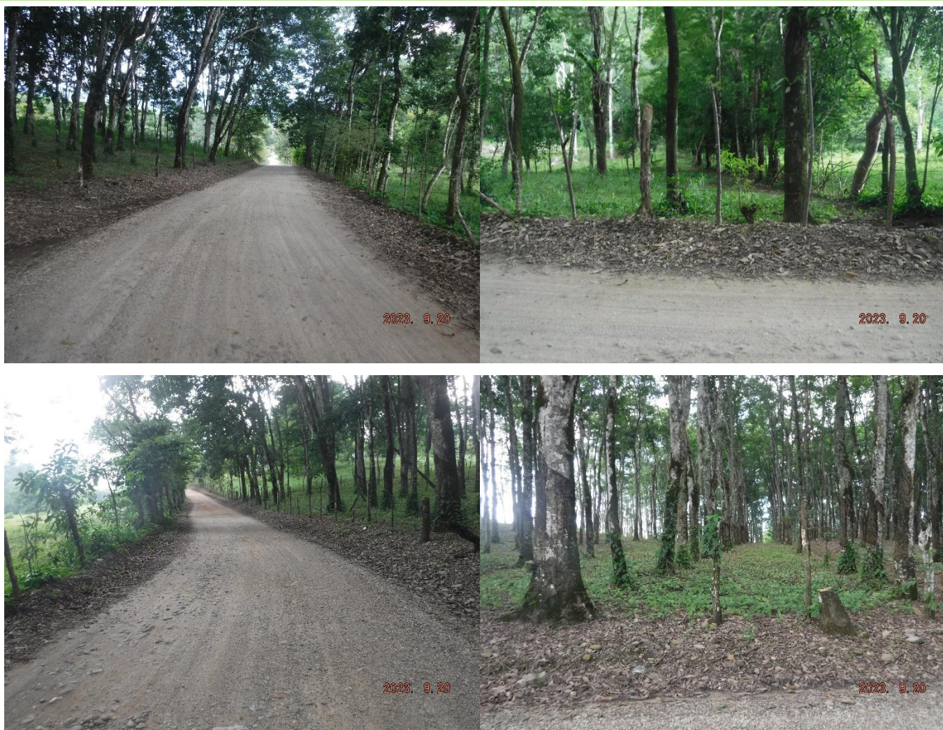
Foto 49 a la 52: Condiciones actuales del km 4+000, los usos de sus colindancias,
