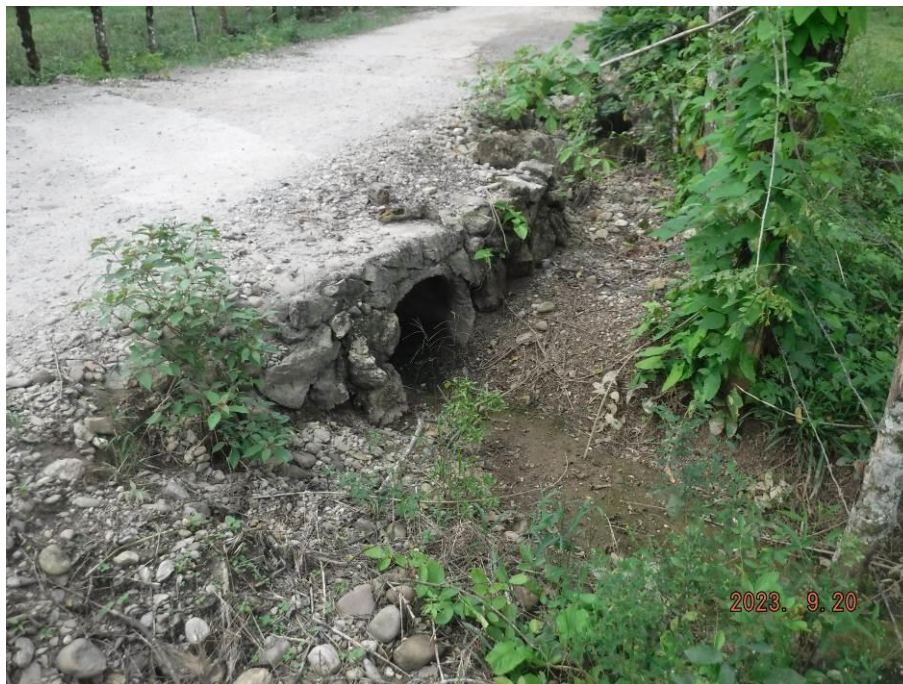
Figura II. 11. Obras de alcantarilla en el km 3+640 del camino.
