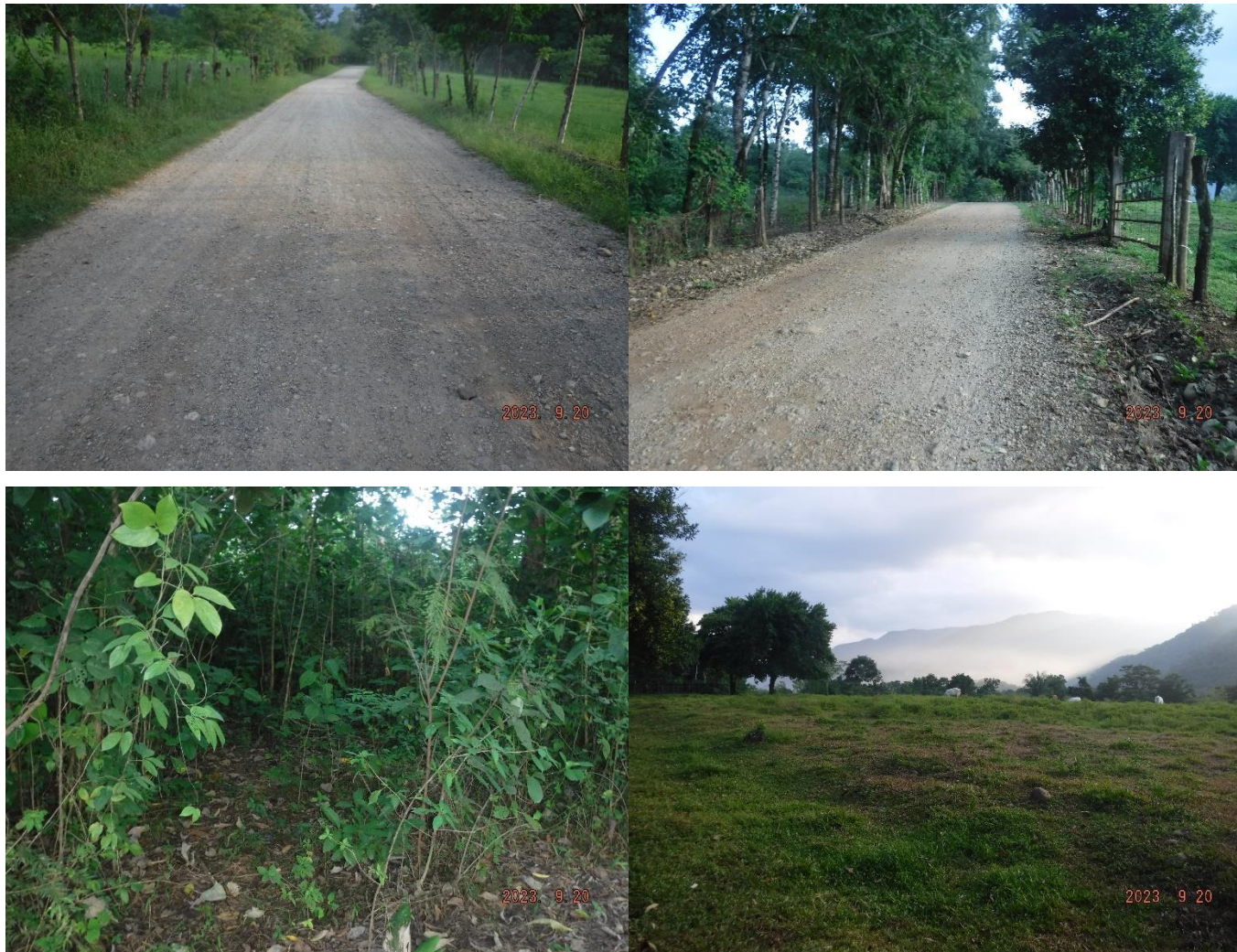
Foto 29 a la 32: Condiciones actuales del km 2+500, los usos de sus colindancias,
