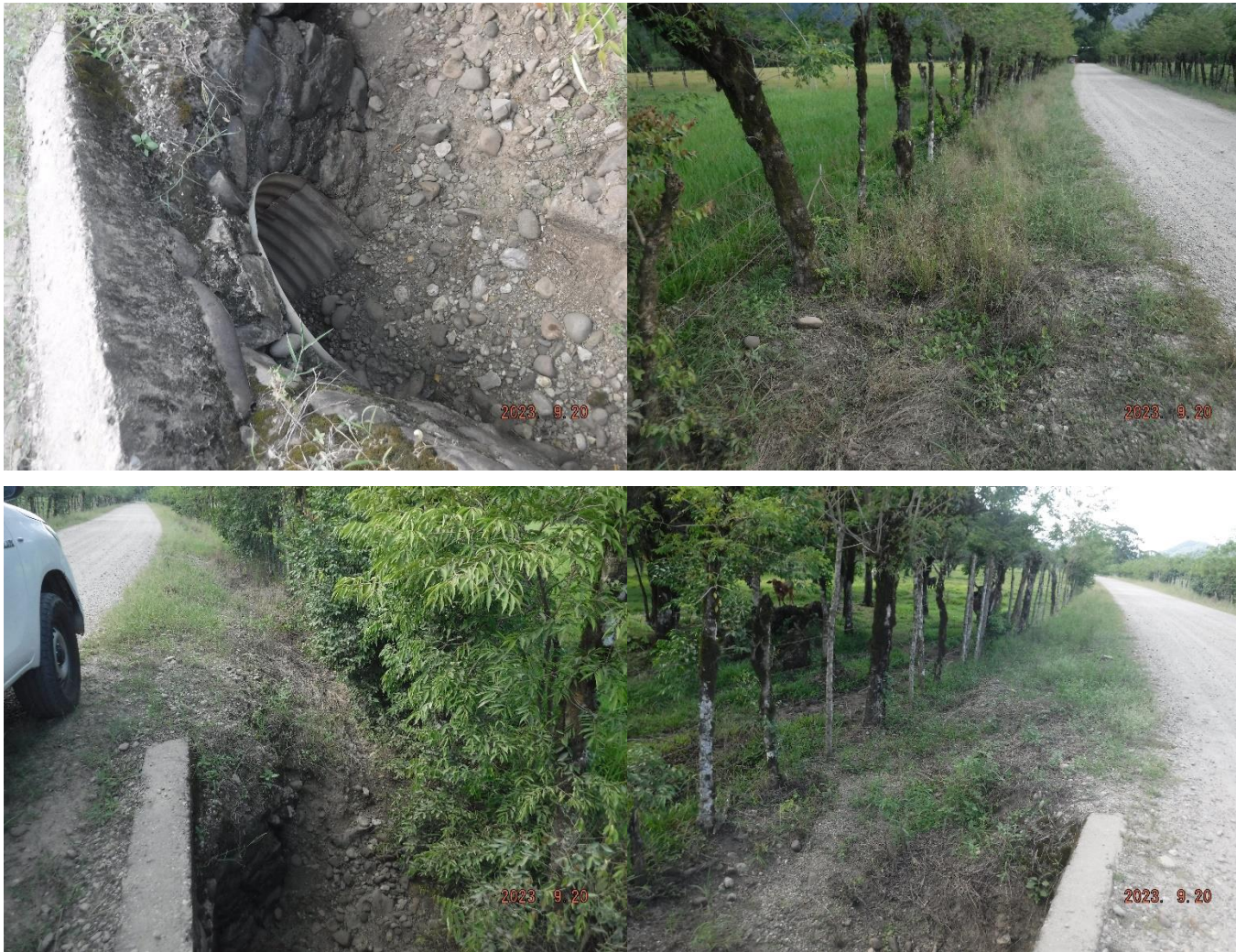
Foto 84 a la 87: Condiciones actuales del km 5+680, los usos de sus colindancias, alcantarillado pluvial.
