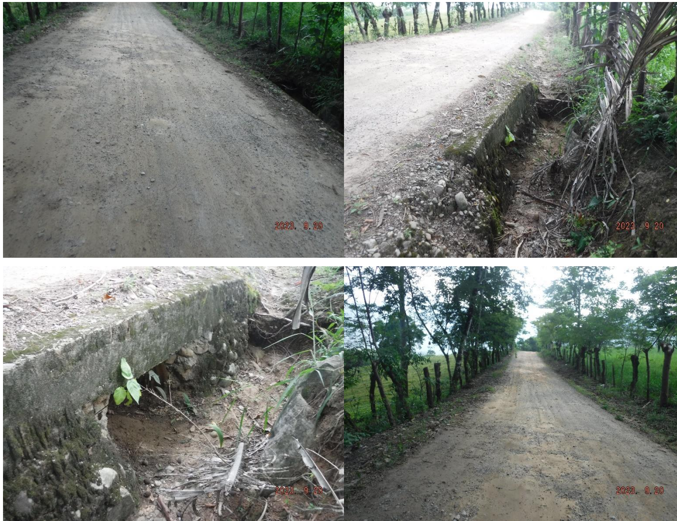
Foto 25 a la 28: Condiciones actuales del km 2+280, los usos de sus colindancias, alcantarillado pluvial.
