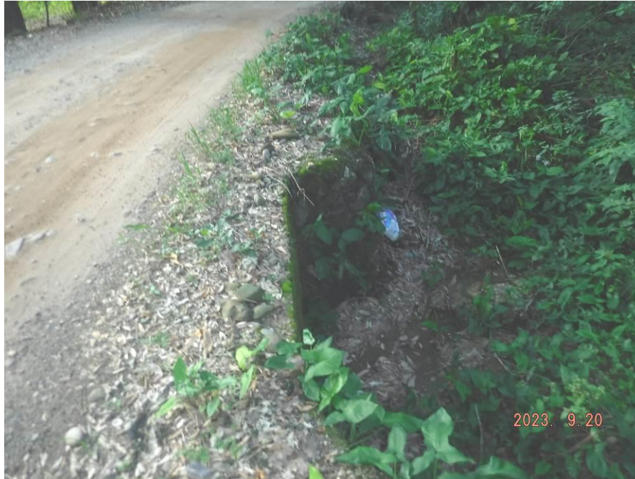
Figura II. 8. Obras de alcantarilla en el km 1+940 del camino.
