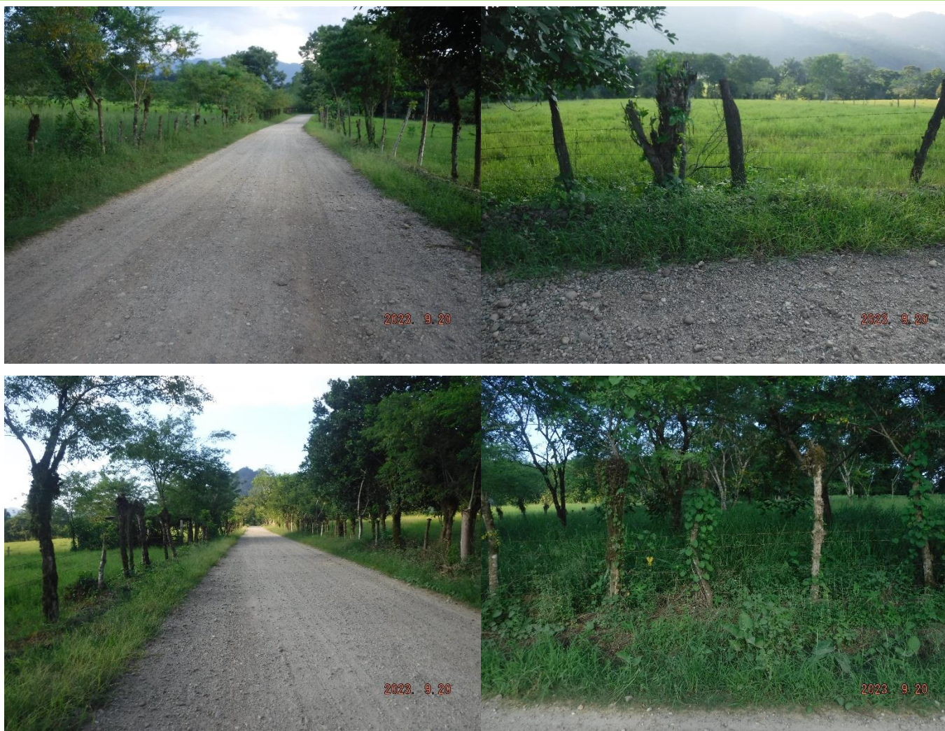
Foto 33 a la 36: Condiciones actuales del km 3+000, los usos de sus colindancias
