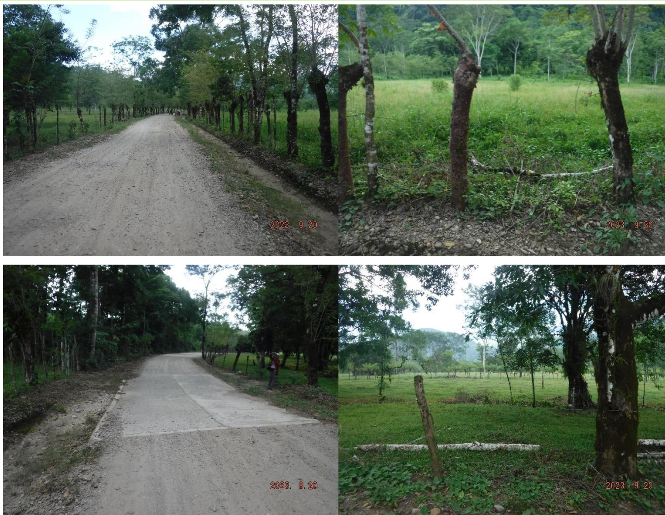
Foto 76 a la 79: Condiciones actuales del km 5+000, los usos de sus colindancias.
