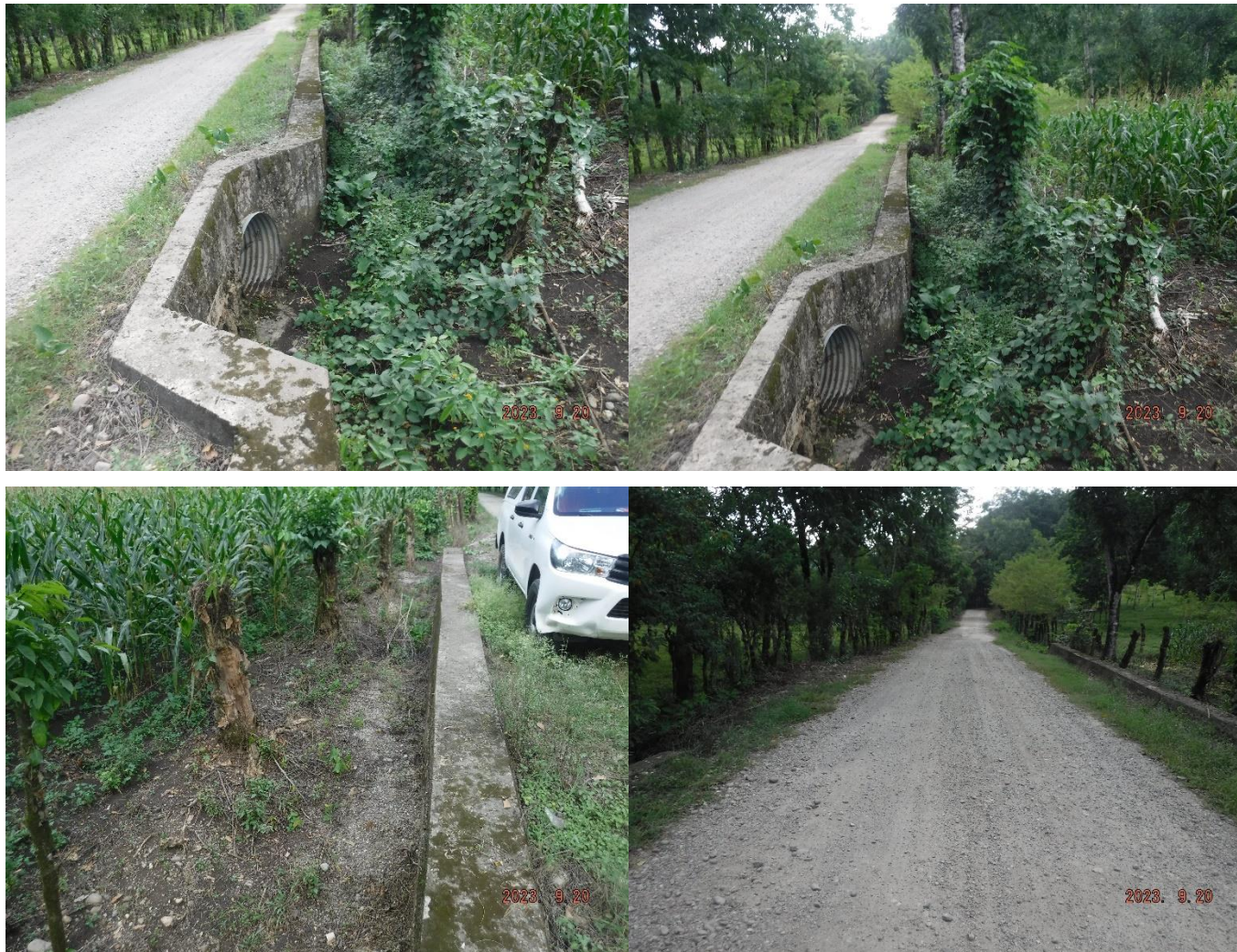
Foto 53 a la 56: Condiciones actuales del km 4+100, los usos de sus colindancias, alcantarillado pluvial.
