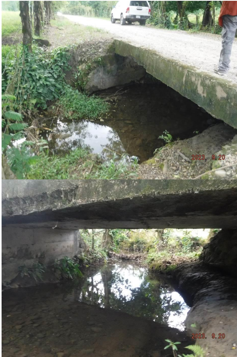
Figura II. 20 y Figura II. 21. Puente y río permanente a la altura del Km 4+440
