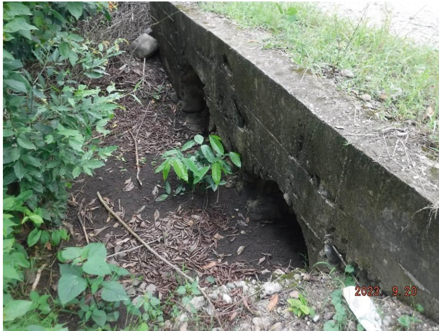
Figura II. 14. Obras de alcantarilla en el km 4+800 del camino.
