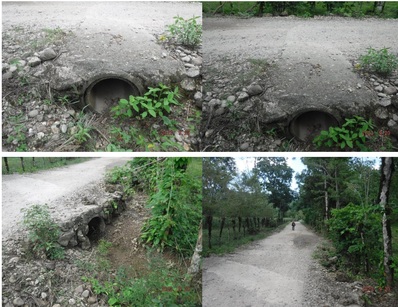
Foto 45 a la 48: Condiciones actuales del km 3+640, los usos de sus colindancias, alcantarillado pluvial.
