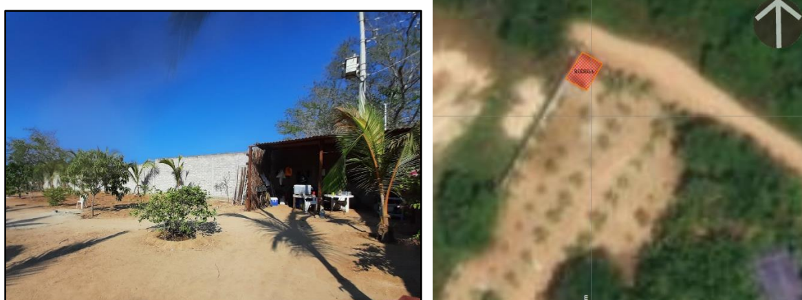
Imagen 6 Techado de lámina utilizado como bodega durante la construcción de la barda
