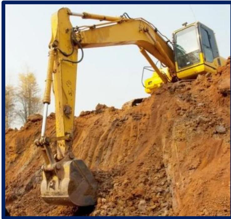
Ilustración II-21 ejemplo de afine de taludes.
