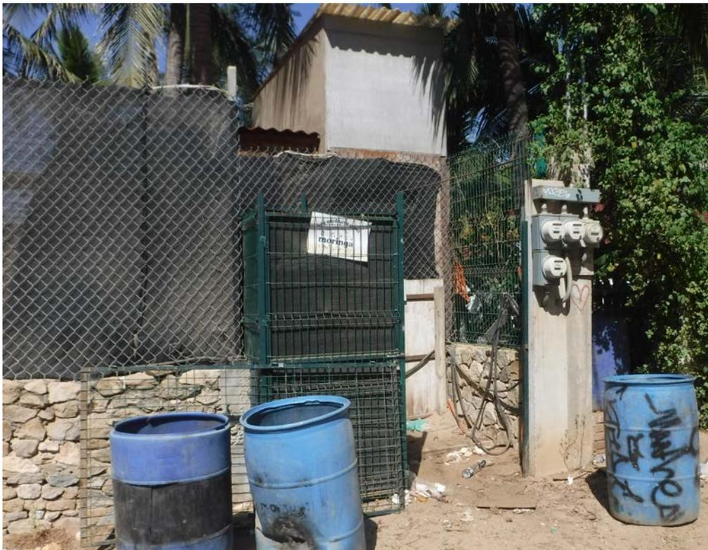
Figura II. 21. Muro de mampostería con malla metálica electrosoldada, bodega de RSU y tablero de medidores de luz.
