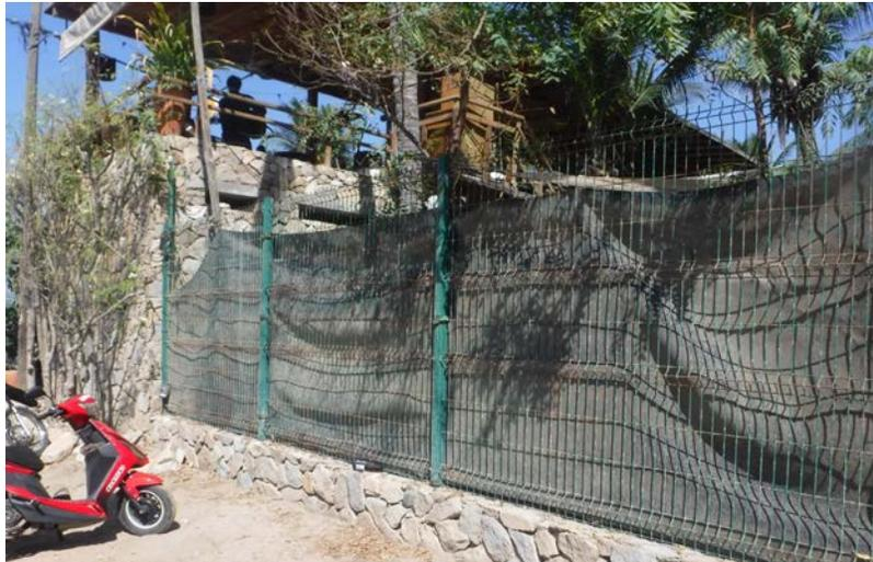
Figura II. 18. Muro de mampostería con malla metálica electrosoldada..
