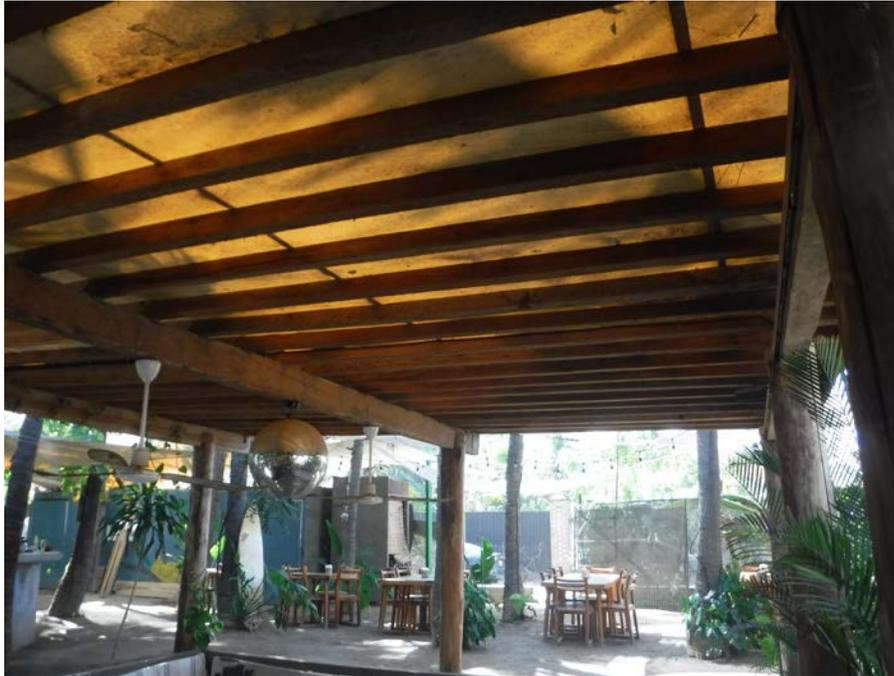
Figura II. 8. Techo de madera del Área a desnivel de forma cuadrangular.
