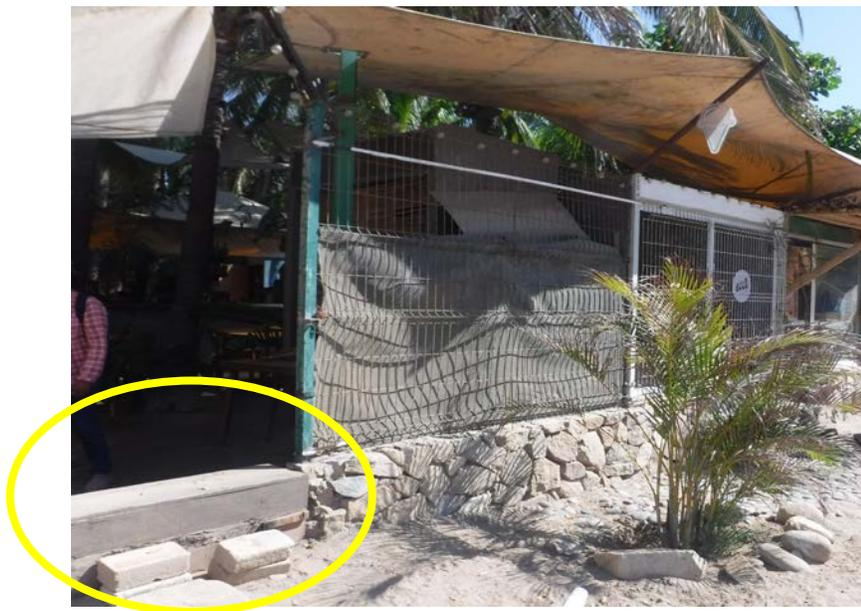
Figura II. 19. Rampa de acceso y Muro de mampostería con malla metálica electrosoldada..
