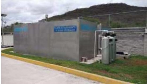
Las Plantas de Tratamiento Compactas WEA, estará construida bajo la ingeniería de diseño patentada por el proveedor, dicha planta captará las aguas residuales provenientes de las actividades humanas y mediante un tratamiento bilógico tratará el agua pasándola por las diferentes etapas del proyecto el cual garantiza el cumplimiento de la NOM-001-SEMARNAT-2021.
