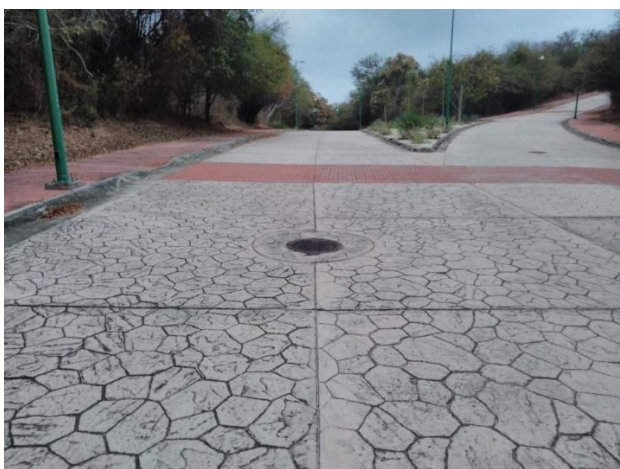
Vialidad pavimentada con concreto estampado, pozo de visita de la red sanitaria al centro.
