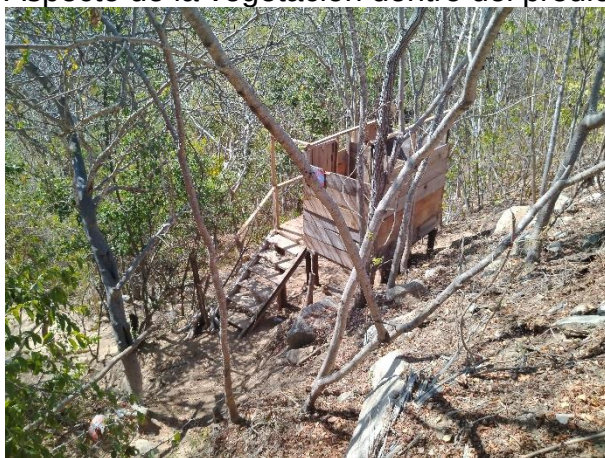
Letrina al aire libre construida en predio colindante
