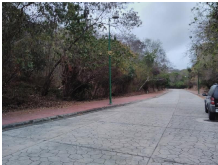
Vialidad y banqueta recubiertas con concreto estampado
