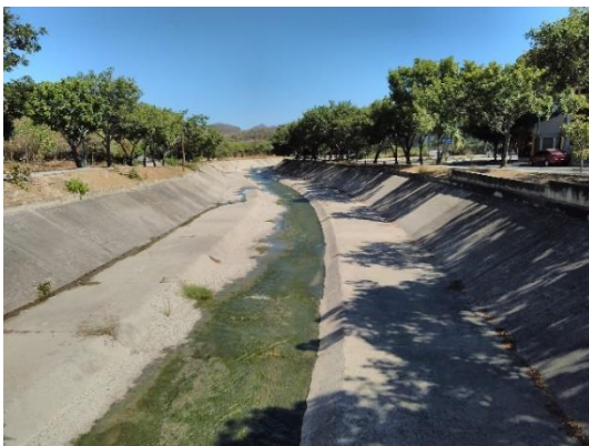
Canal Chahue que recibe aportaciones del arroyo Chahue
