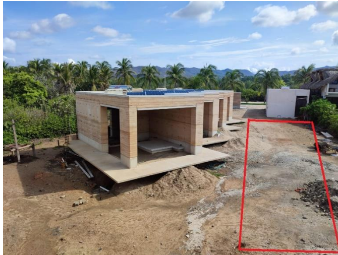
ILUSTRACIÓN II-6 AREA DE PREPARACION DE TIERRA MEZCLAPARA MUROS.
