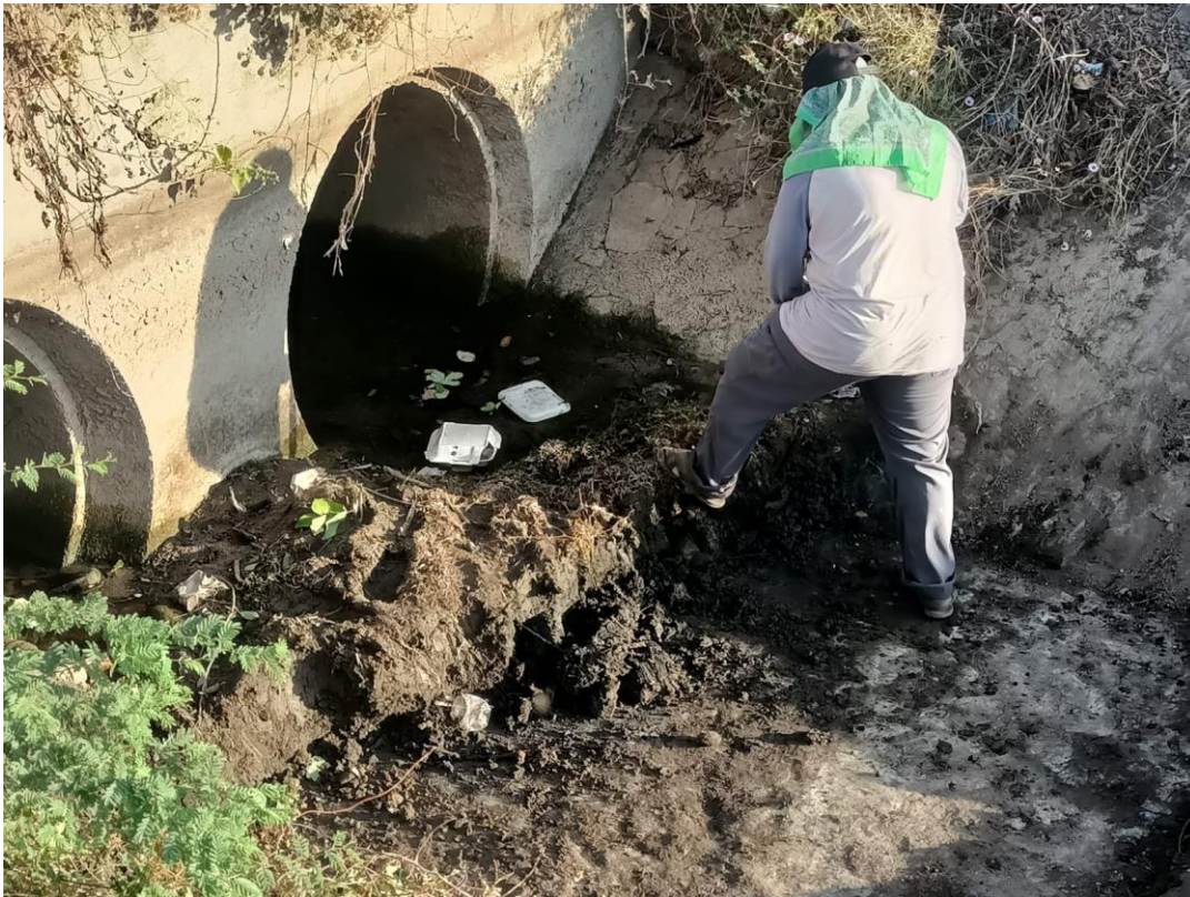
Ilustración II-6 limpieza del canal de manera manual.
