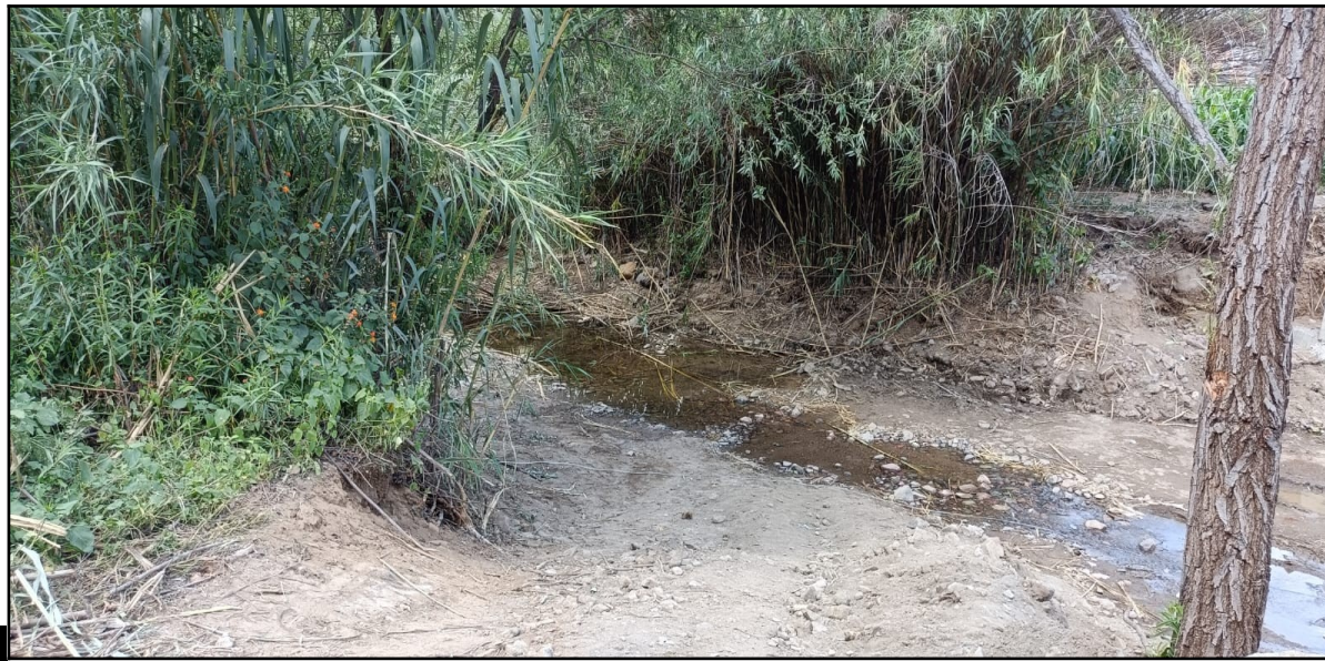
Fotografía 1. Vista del sitio del proyecto en donde se construirá el puente vehicular. En temporada de lluvias se complica el acceso peatonal y vehicular a parte de la zona urbana localizada al poniente de la población de San Miguel del Valle.
