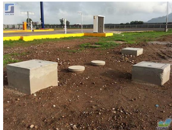
VISTA FINAL DEL MÓDULO YA INSTALADO
