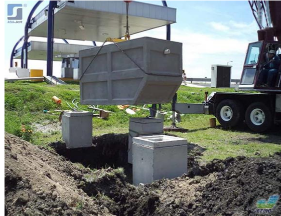
APERTURA DE CEPA PARA INSTALACIÓN DE MÓDULO
