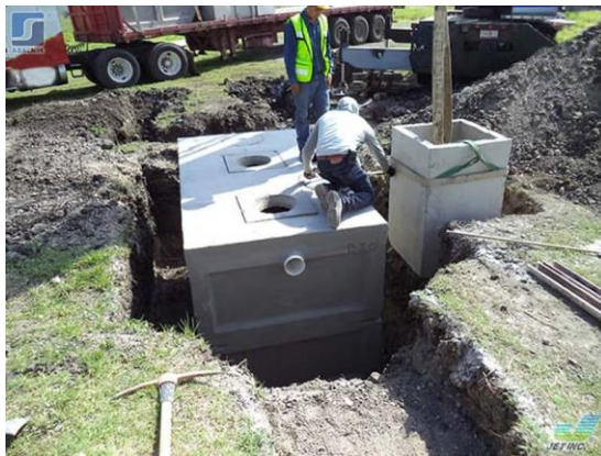
ARMADO DEL MÓDULO DENTRO DE LA CEPA
