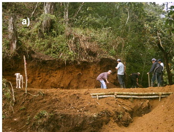
Figura III.29. Ejemplos de áreas de trabajo de zonas perforación elaborados exclusivamente con gente y en donde no se utiliza maquinaria, bajo impacto.
