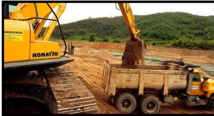
**Figura II.17. Extracción de materiales pétreos de río mediante el método en greña.**
