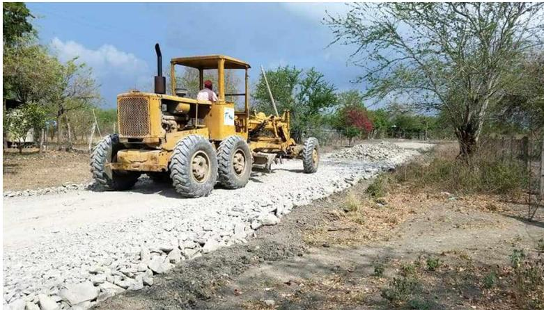
**Figura II.17.** Ejemplo de una motoconformadora a utilizar para el tendido de material triturado como capa superficial del camino.
