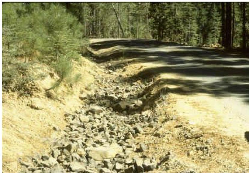
**Figura II.19.** Ejemplo de cuneta a conformar, la cual se ubicará en el borde interior y estará acorazada con rocas bien graduadas para el control de la erosión.
