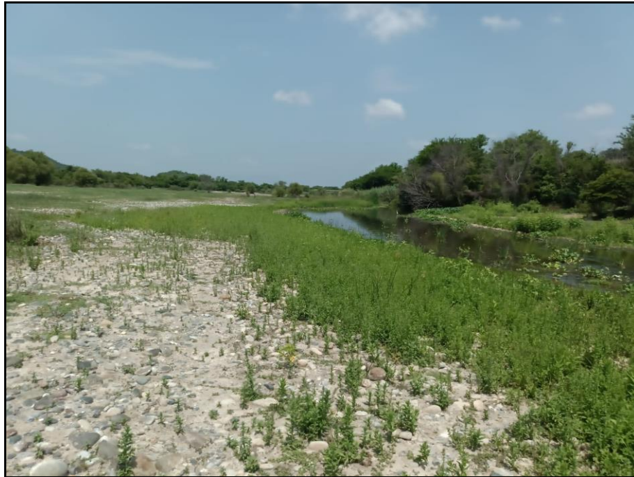
Fotografía 3. La ejecución del proyecto aportará beneficios ambientales por el desazolvamiento del río, dado que ayudara a reducir afectaciones a la vegetación aledaña que ha sido afectada por el desbordamiento de su cauce.
