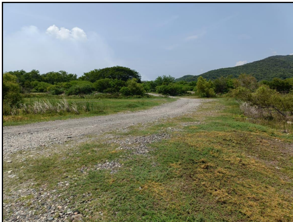
Fotografía 7. Condiciones del camino de acceso interno al río Tehuantepec.
