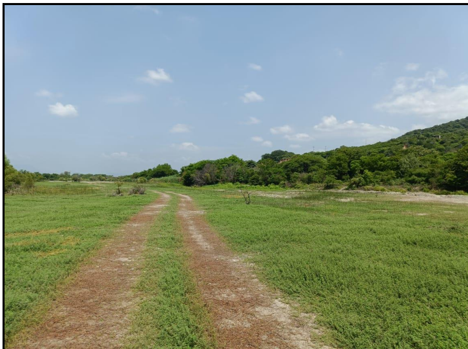
Fotografía 6. Condiciones del camino de acceso al río, el cual será revestido con material del mismo banco, para facilitar el rodamiento de los vehículos de carga y maquinarias.
