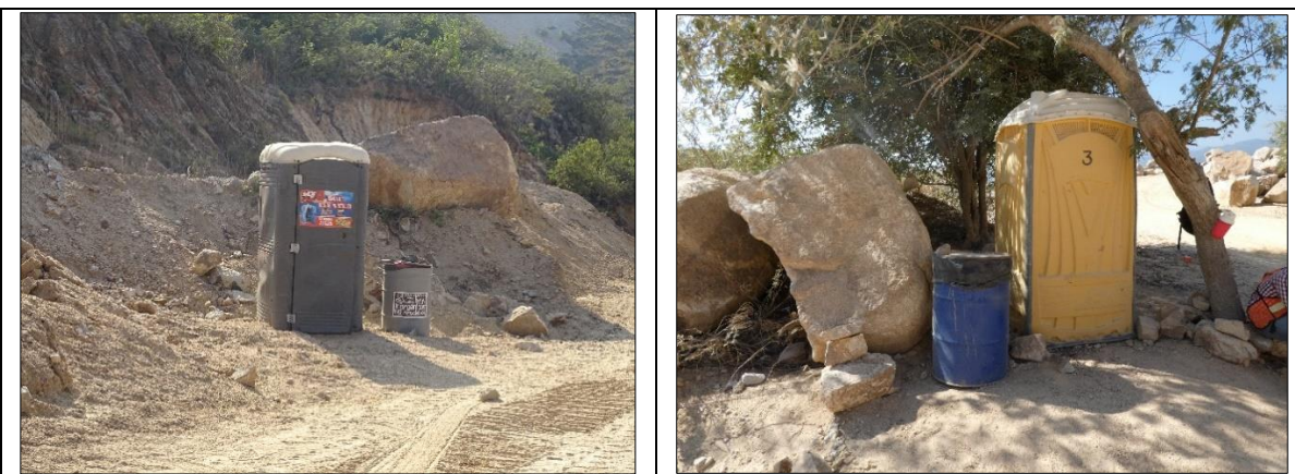
Ejemplo de sanitarios a instalar en los frentes de trabajo, estas fotografías corresponden a un proyecto de la misma naturaleza ejecutado en el Istmo de Tehuantepec.
