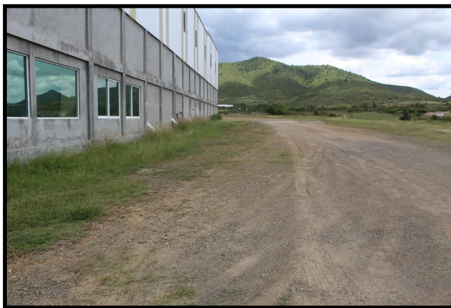
Figura IV.77. Vista frontal del polígono del proyecto.
