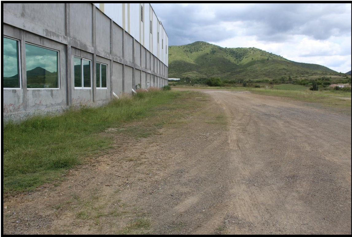
Figura IV.67. Vista frontal del polígono del proyecto.
