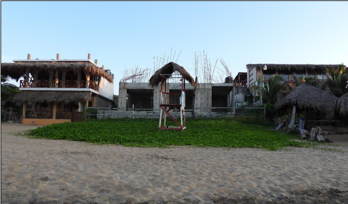
Fotografía. Vista frontal del proyecto, donde se observa la infraestructura existente.
