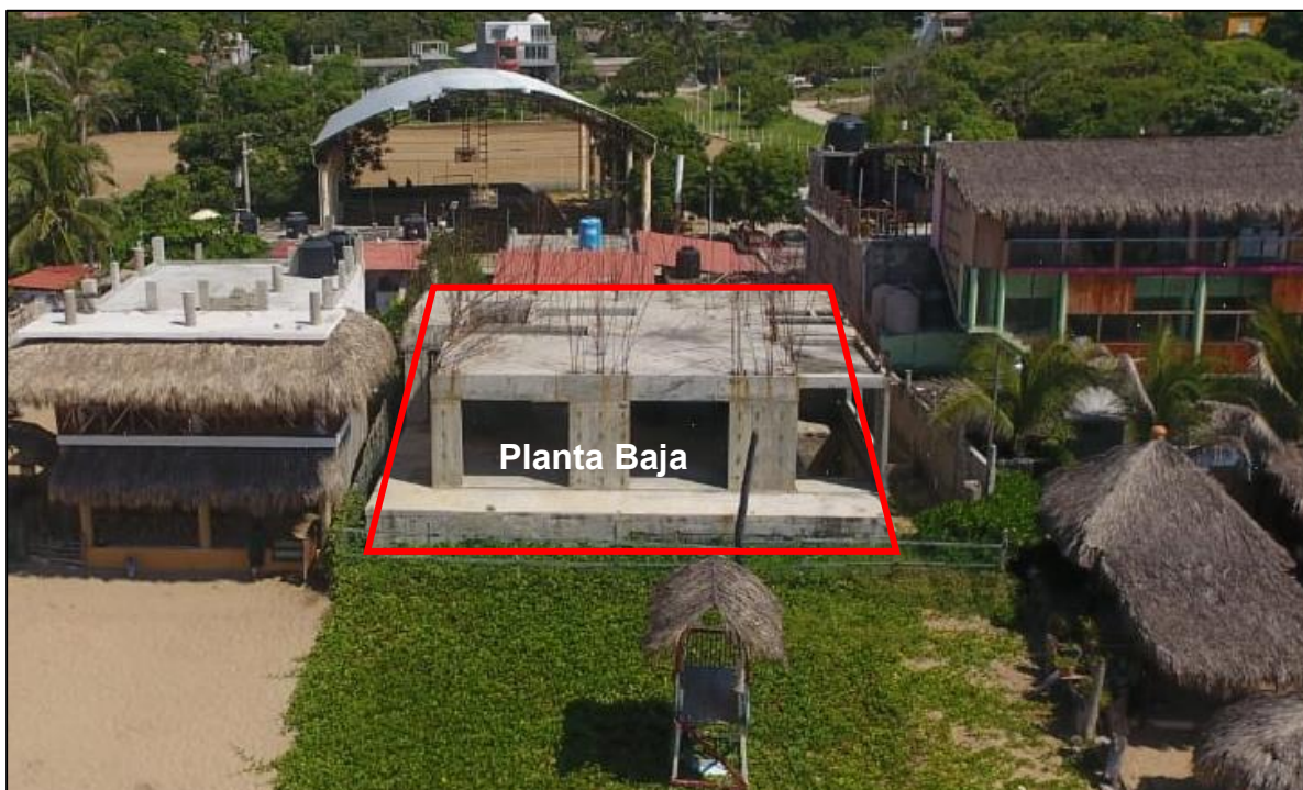
Imagen. Fotografía aérea frontal de las Plantas del conjunto arquitectónico de “Casa Ricky”, ubicada en Zipolite, en el Municipio de San Pedro Pochutla, en el estado de Oaxaca.
