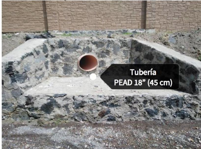
Figura II.5. Ejemplo de descarga pluvial con tubería en otras descargas del complejo Lomas de Angelópolis.
