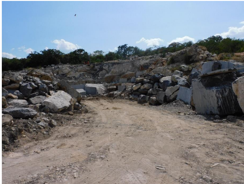
Figura 1. Rampa de acceso que se habilitaron en el banco de material para llegar al tajo.
