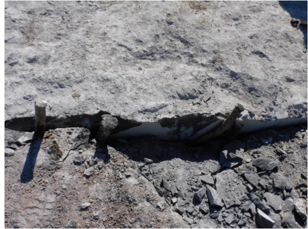
Figura 7. Perforación neumática y colocación de cuñas guiadas.
