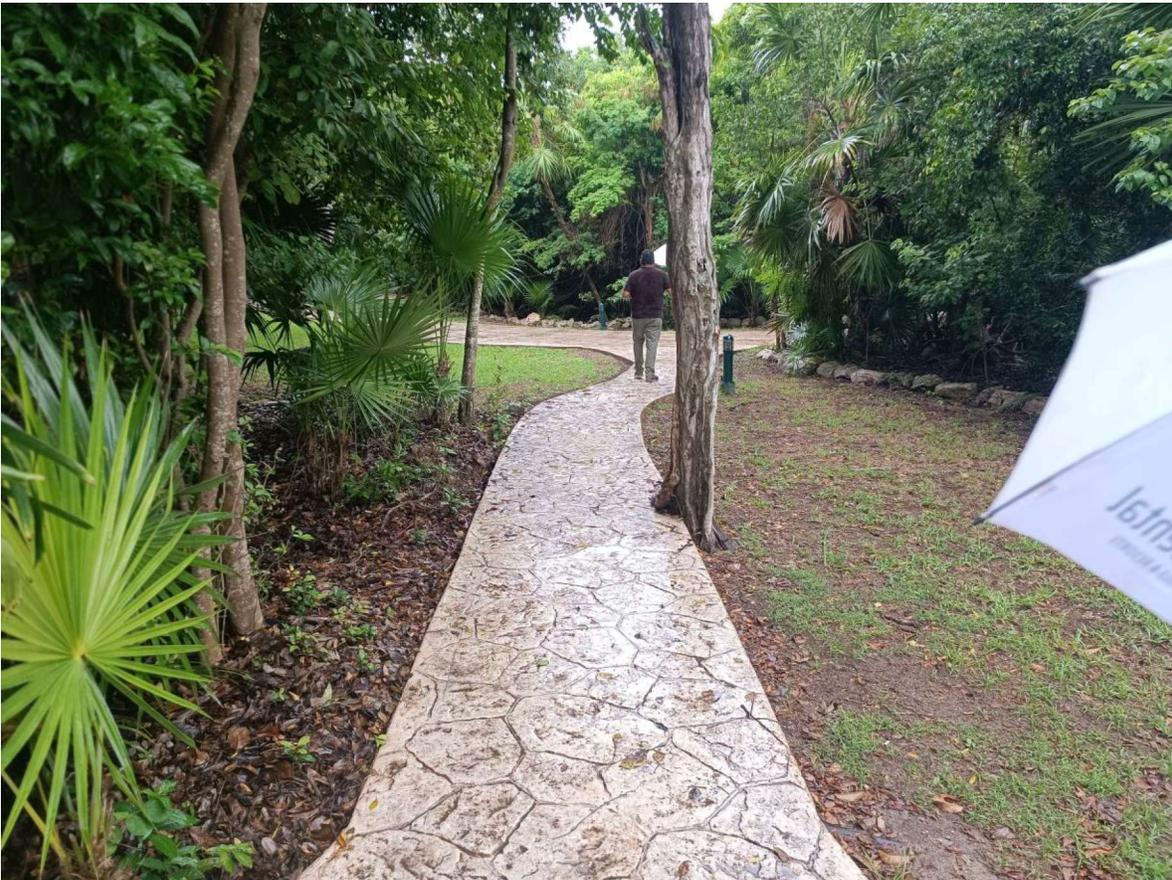
H. Tramo de andador interno que en el Acta de inspección PFPA/4.1/2C-27.5/016/17, se identificó como tramo 5, con dimensiones aproximadas de 2.5 m de ancho y 44.2 m de largo, lo que arroja una superficie aproximada de 110.5 m<sup>2</sup>, construidos con concreto estampado.
