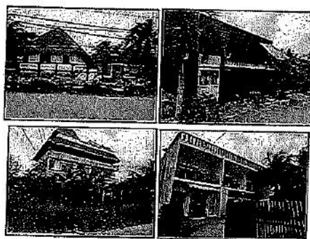
Figura III.4 Infraestructura observada en la zona
