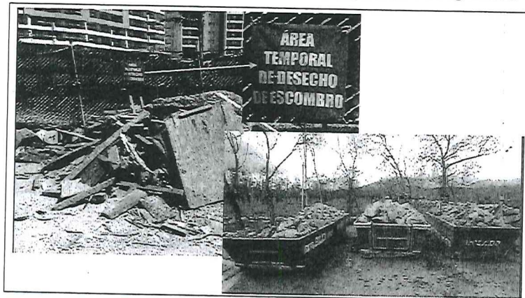
Figura 3. Ejemplo de un área de acopio temporal de residuos de construcción a ras del suelo en una obra y de los contenedores que se pueden utilizar para la contención de estos.
