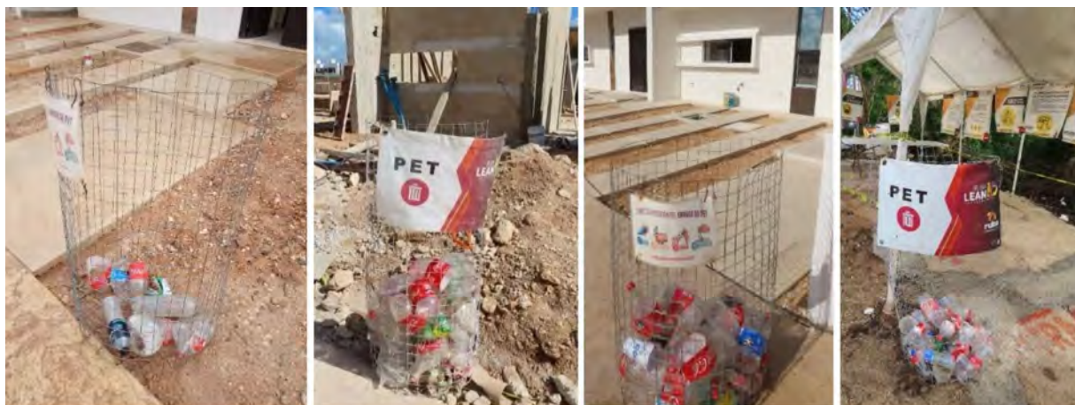
Figura 7. Contenedores distribuidos en obra para el acopio de PET.
