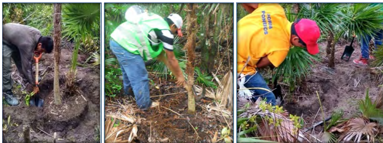
Figura 23. Construcción de la zanja de banqueo.
