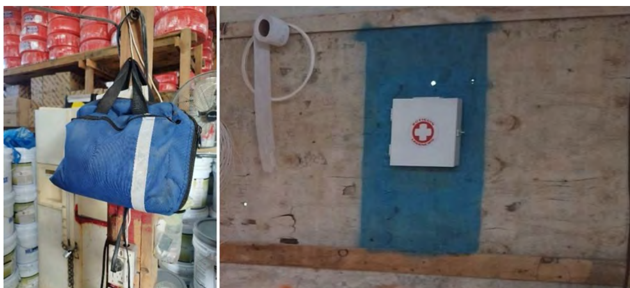
Figura 16. Ejemplo de botiquines de primeros auxilios instalados en obra.
