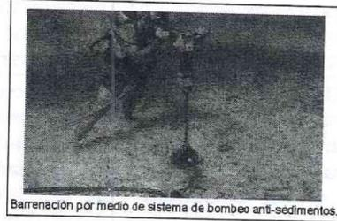
Barrenación por medio de sistema de bombeo anti-sedimentos.
