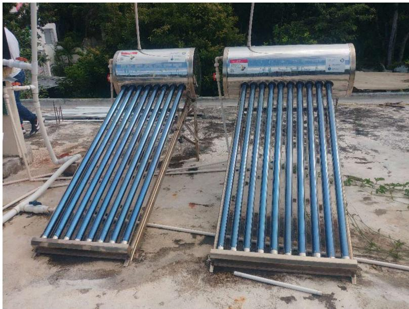
**Imagen II.6. Calentadores solares utilizados en el proyecto.**
