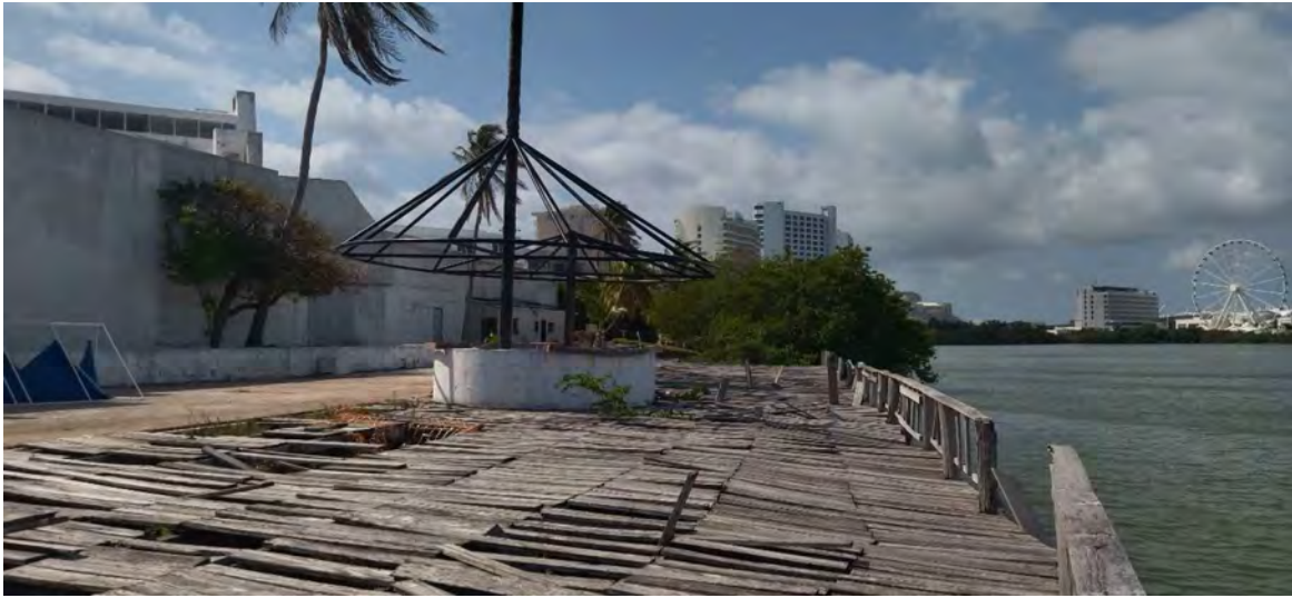
Figura II:2. Deck de madera existente que será remodelado
