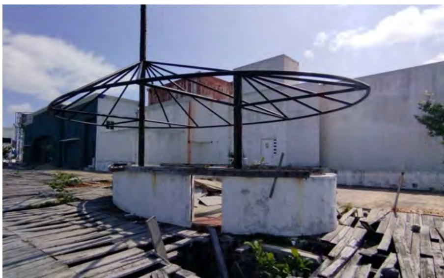
Figura II:4. Estructura para palapa en el sitio del proyecto.
