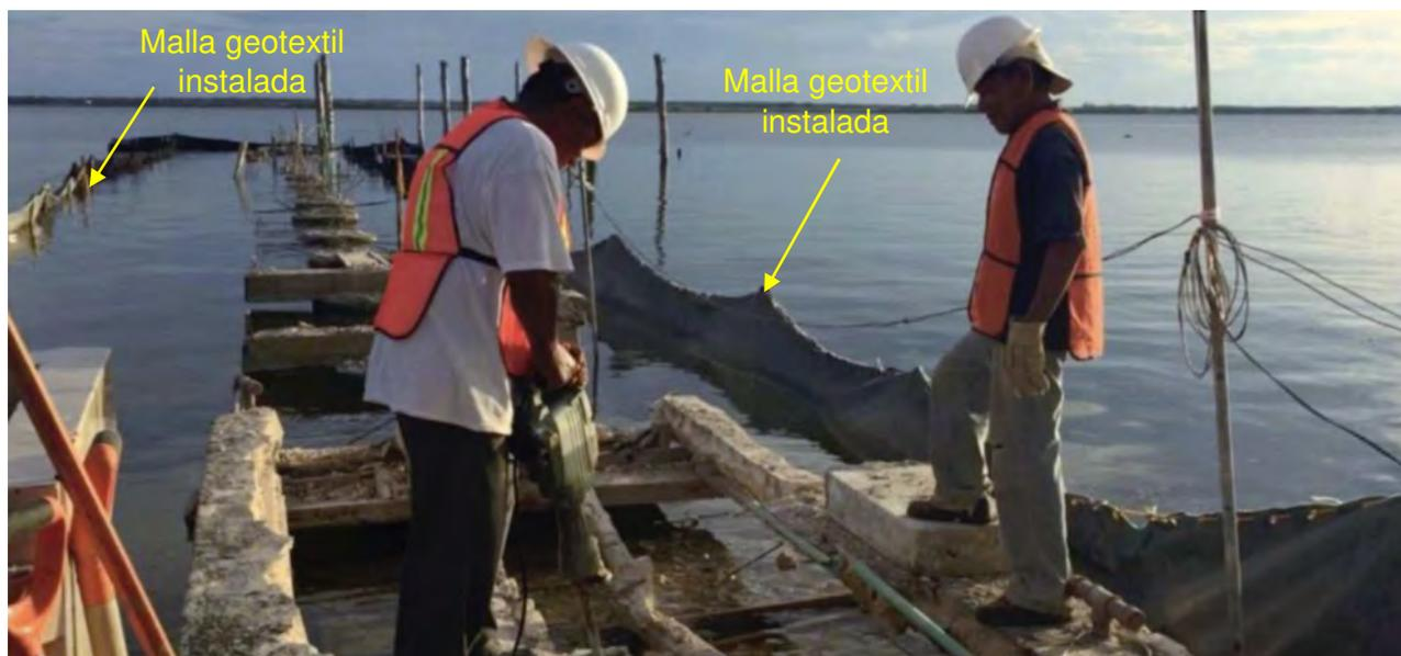
Figura 36. Malla geotextil en uso. Tomado de: <http://noticaribe.com.mx>
