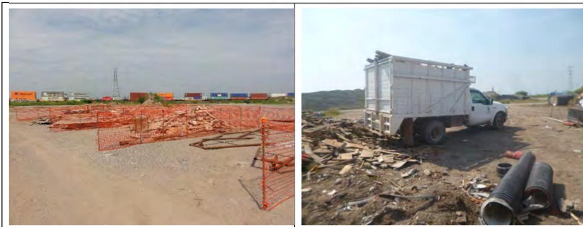
Figura II-4. Ejemplo del acondicionamiento y diferenciación y colecta de residuos sólidos urbanos y de manejo especial en proyectos en construcción.
