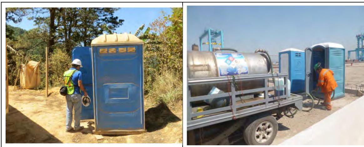
Figura II-3. Ejemplo de la habilitación y mantenimiento de baños portátiles instalados en frentes de trabajo para uso de los trabajadores.
