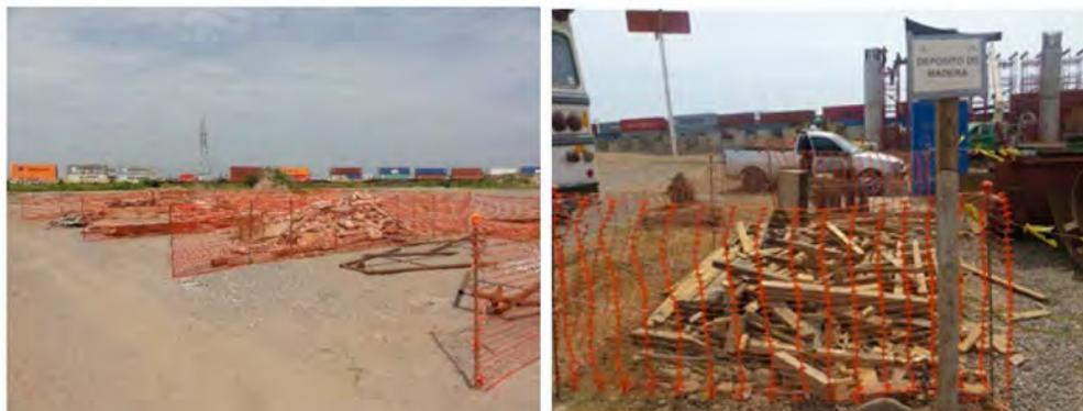
Figura II-9.- Ejemplo de la Almacenes temporales debidamente señalizados, para la disposición de residuos de manejo especial durante la etapa de construcción.
