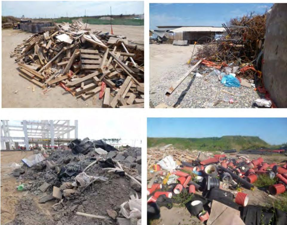
Figura II-8.- Ejemplo de evidencias del mezclado durante la disposición temporal de residuos de manejo especial durante la etapa de construcción.
