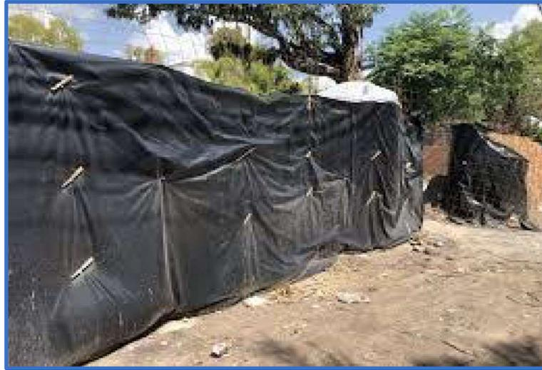
*Figura 18. Colocación de malla de retención de polipropileno para delimitar el área de trabajo de obra.*
