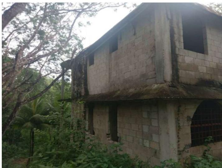
**Una construcción construida con material de concreto** en una superficie de 4 metros cuadrados, dicha construcción se encuentra en la porción Nor-Oeste del predio, observándose las paredes deterioradas, agrietada y con exposición de varilla.
