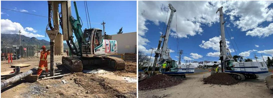
*Figuras 20 y 21. Ejemplos representativos de perforadoras y grúas para los trabajos de cimentación de pilas.*
