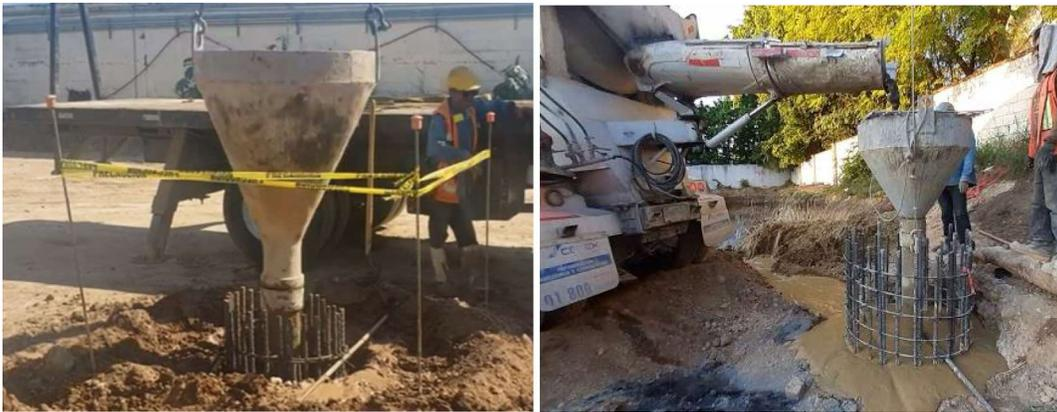
Figuras 27 y 28. Ejemplos representativos del vertido de concreto mediante el sistema Tremie.
