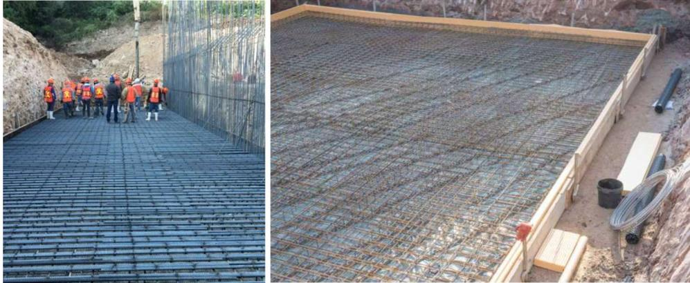
*Figura 29. Ejemplo de proceso constructivo de losas de cimentación.*
