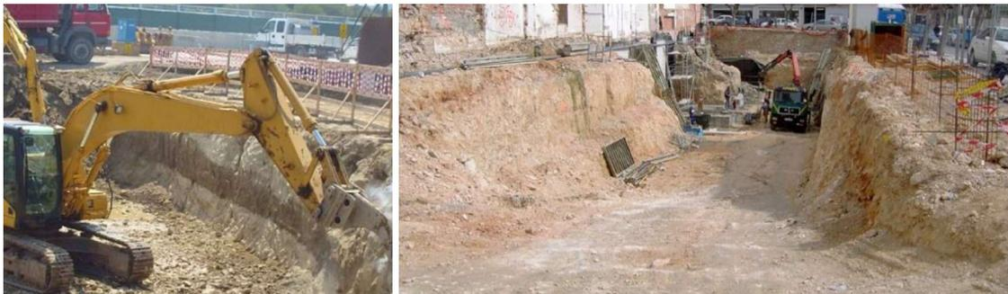
*Figura 13. Ejemplo de maquinaria y trabajos de excavación para la construcción de las rampas del paso a desnivel.*
