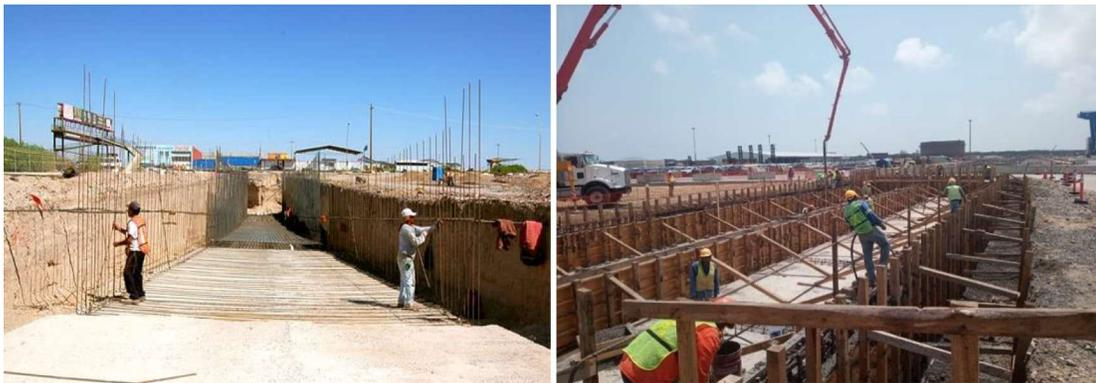
*Figura 30. Ejemplo de armado y cimbrado para la construcción de muros laterales.*
