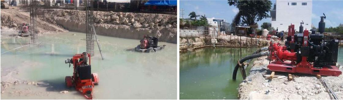
Figura 14. Ejemplo de bombeo para el manejo del nivel freático, bombas de achique colocadas en zonas puntuales.
