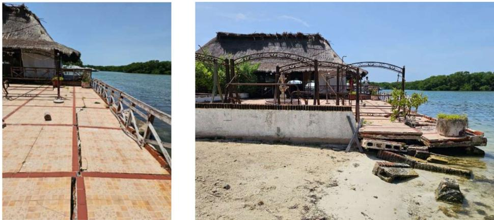
**Imagen 2.** Este muelle es parte de la terraza de concreto, el cual se fracturó por lo que debe ser reparada la terraza completa.
