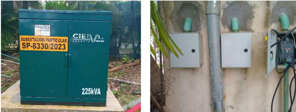
**Imagen 79.** Subestación eléctrica y tableros de control.
