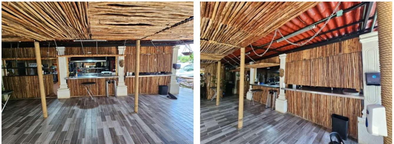
**Imagen 37.** Pasillo de acceso utilizando la misma estructura de soporte estructural; también se aprecian las columnas de apoyo reparadas y cubiertas.
