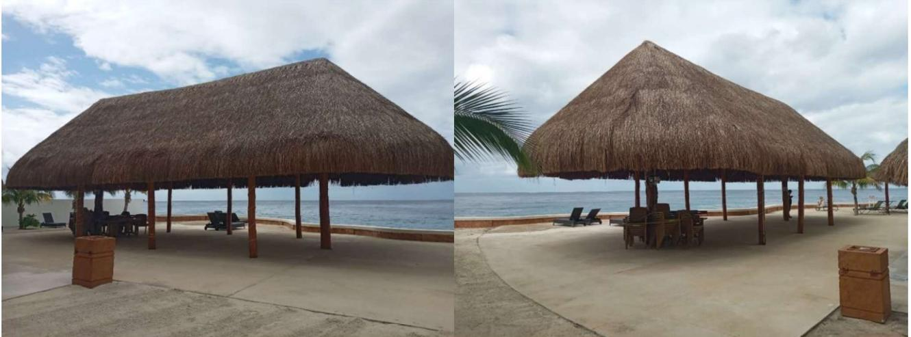
Figura 2. Panorama de la palapa, construida con madura de la región y techo de zacate (pasto) y su piso.
