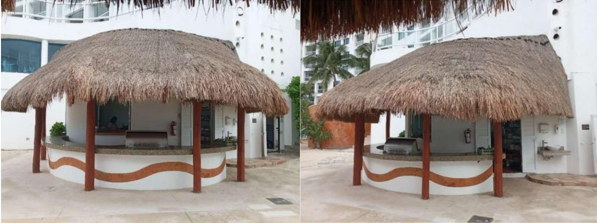
Figura 4. Panorama de la cocina, con estructura de bock, con su barra y techo de zacate.
