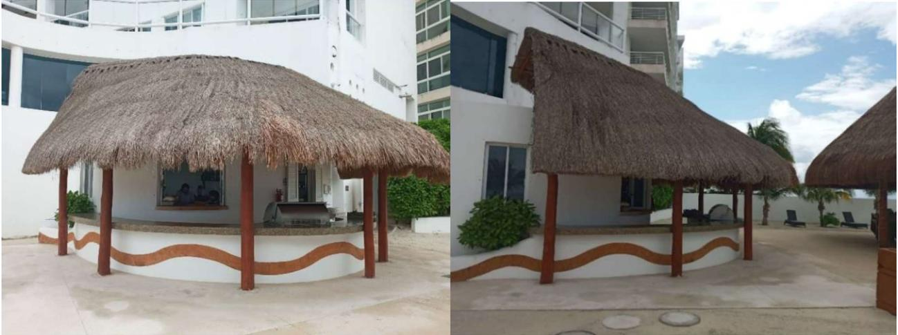
Figura 16. Panorama de la cocina, con estructura de bock, con su barra y techo de zacate.
