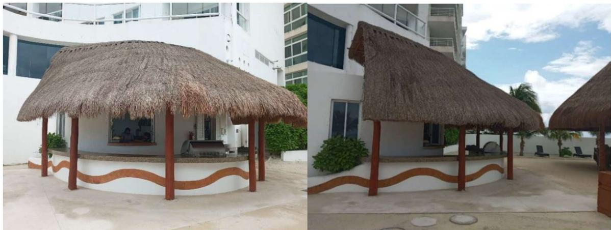
Figura 5. Panorama de la cocina, con estructura de bock, con su barra y techo de zacate.
