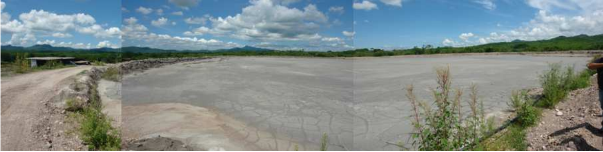
PRESA DE JALES 2
