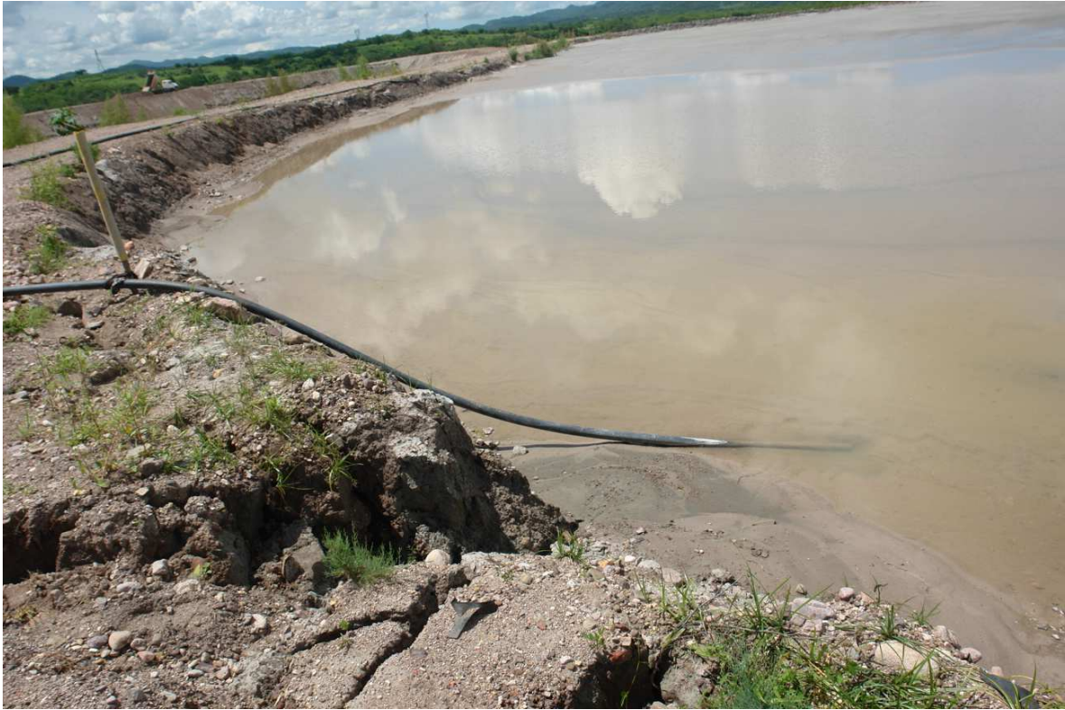
PRESA DE JALES 1
