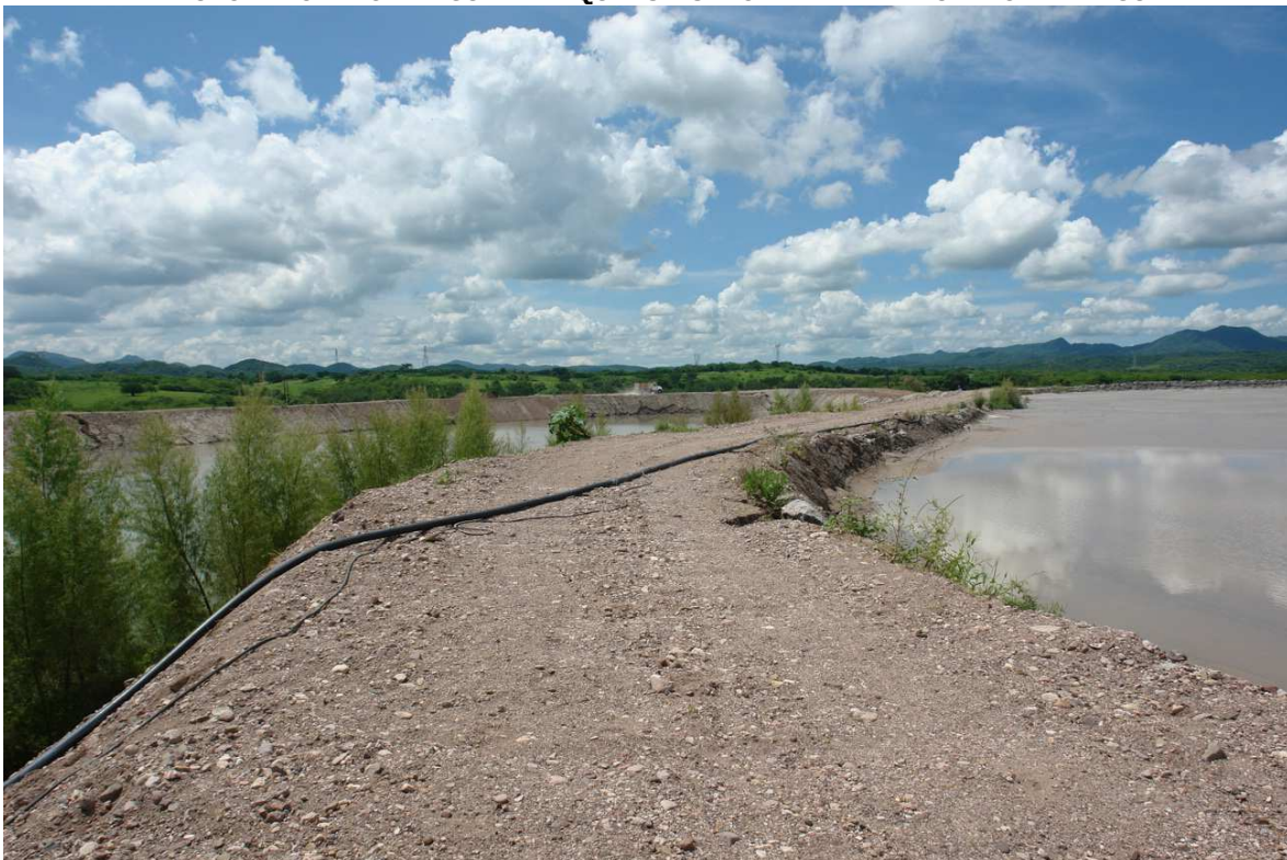
TUBO REBOMBEO DE AGUA A TANQUE ESPESADOR Y PILA ALMACNADORA DE AGUA
