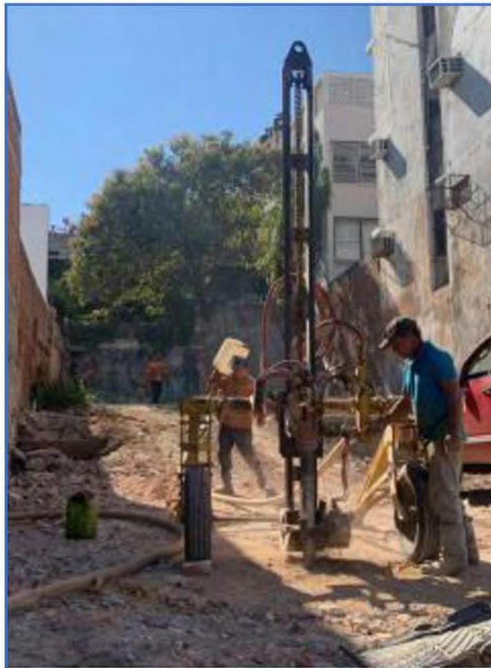
**Figura II.22.-** Equipo empleado para el avance en roca.
