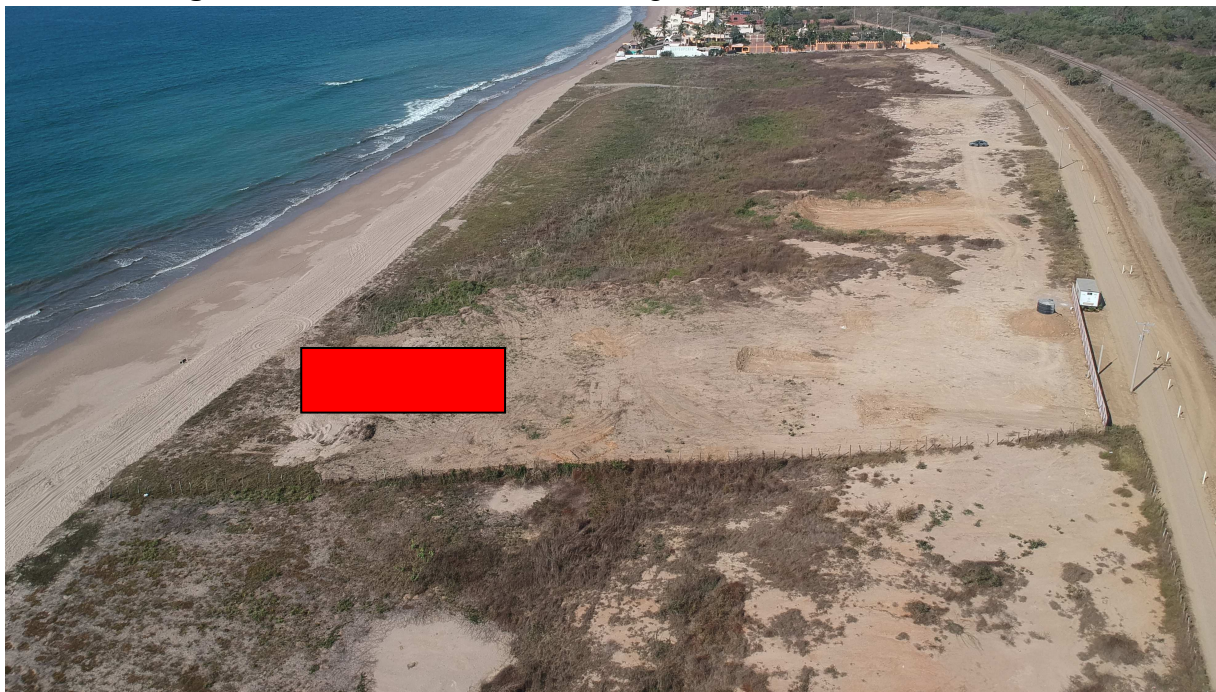
Fotografía II.9. Planta tratadora de Aguas Residuales subterránea.
