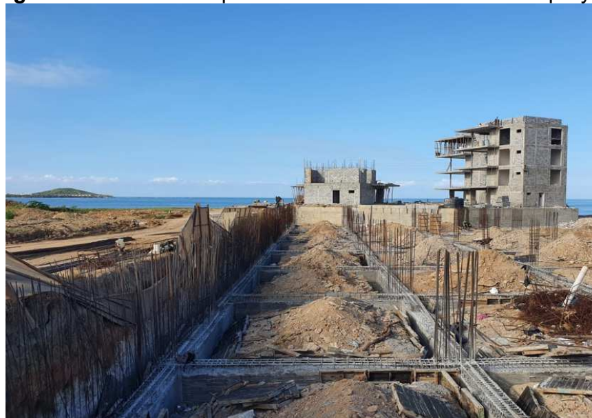
Fotografía IV.3. Vista del predio con la construcción actual proyecto.
