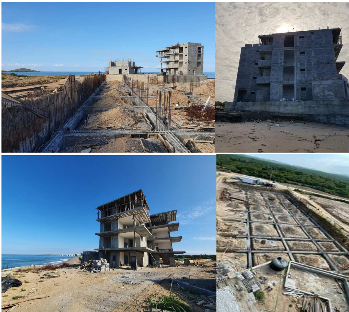
Fotografía II.2. Interior de las edificaciones.
