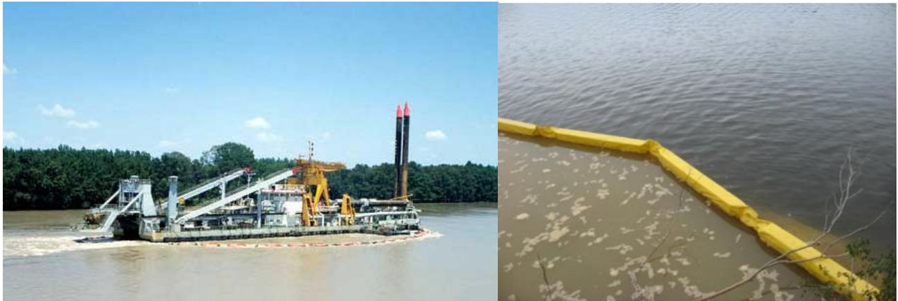
Figura 1. Dragado hidráulica de succión utilizando pantalla de sedimentos finos (silt curtain), nótese a la derecha la eficiencia en la contención
