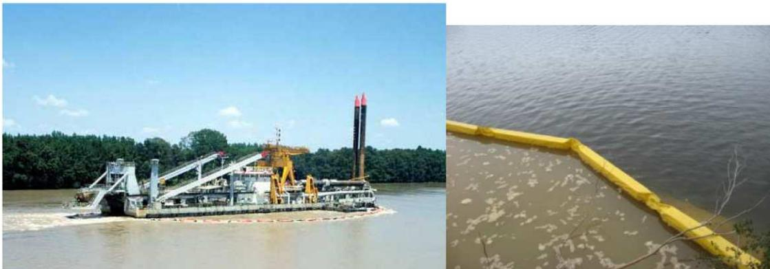
Figura 1. Dragado hidráulica de succión utilizando pantalla de sedimentos finos (siltocourtain), nótese a la derecha la eficiencia en la contención
