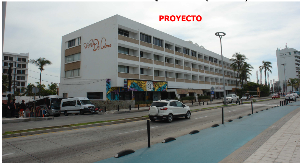
VISTA DESDE AV. DEL MAR ESQ, CALLE HAMM (EDIFICIO A)
