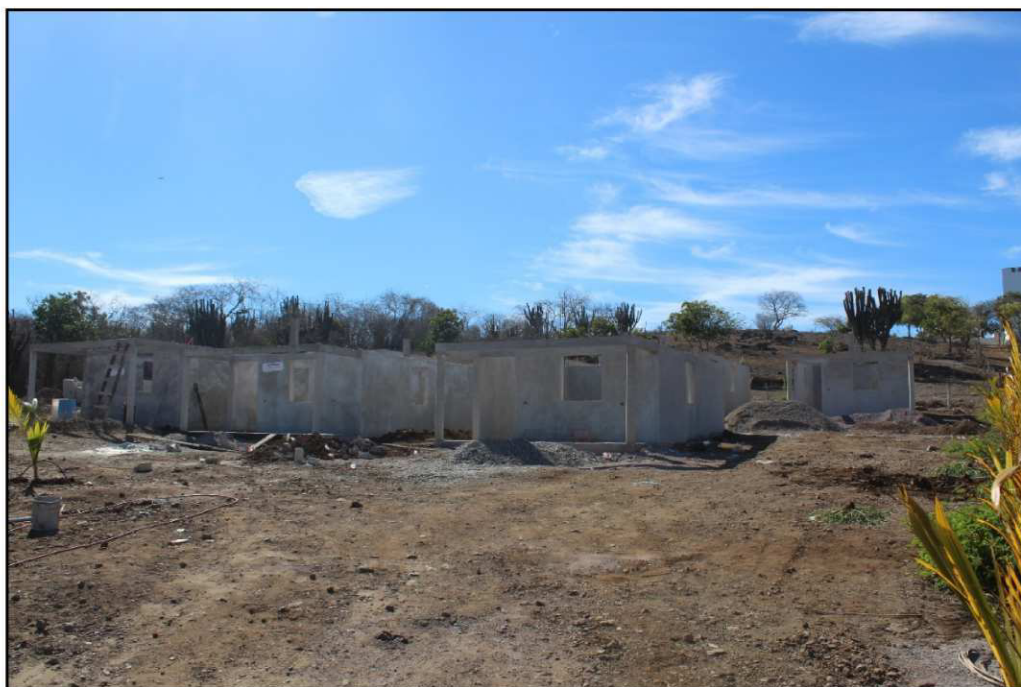
Fotografía No. 1. Cabañas en construcción del área del proyecto.
