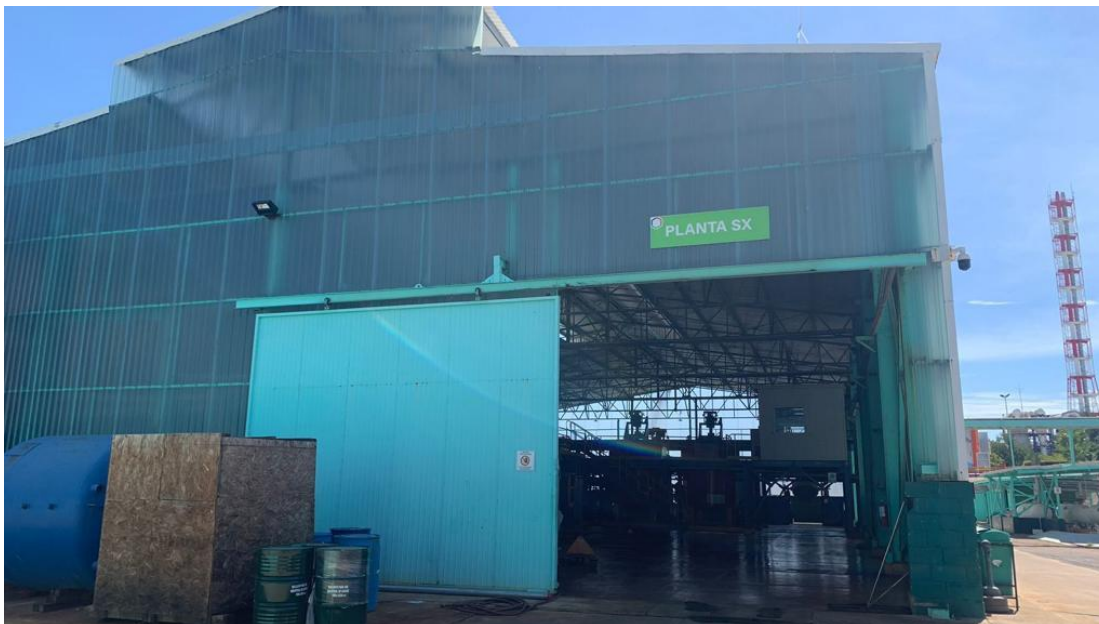
Planta de tratamiento de residuos de molibdeno
