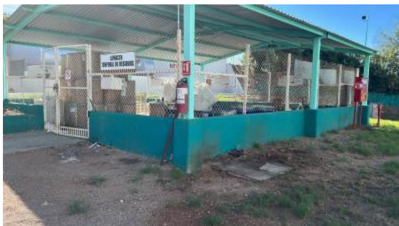
Almacén temporal de residuos peligrosos
