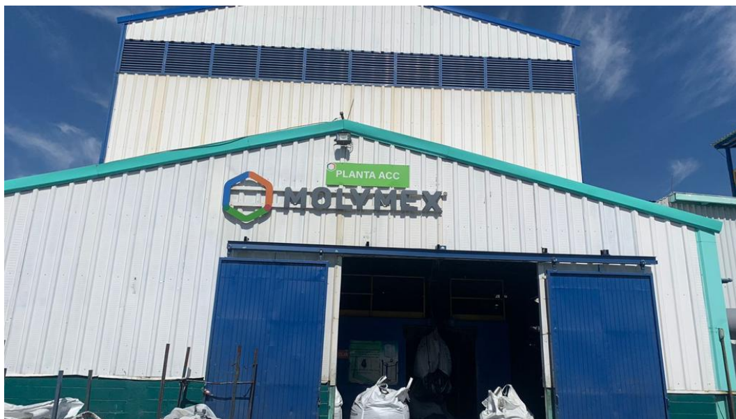
Planta de acondicionamiento de concentrados (planta ACC)
