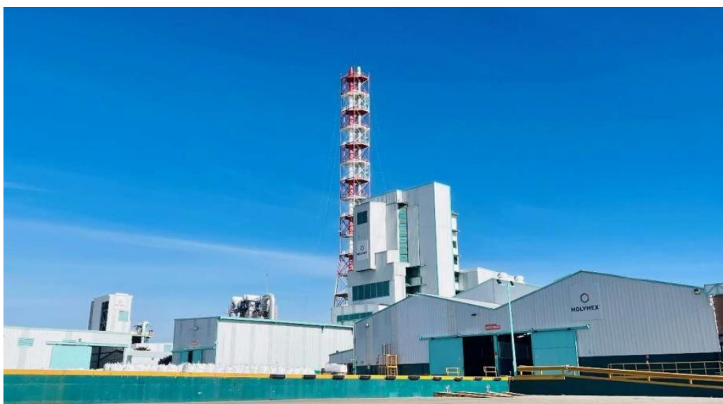
Chimenea para la emisión de gases tratados
