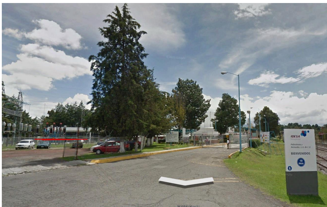
FIGURA 44. VISTA DE LA ENTRADA A LAS INSTALACIONES DE NOVIDESA, S.A. DE C.V.
