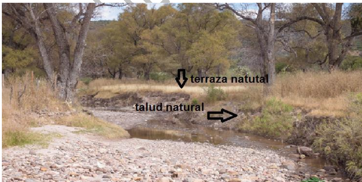
Ilustración 7. Talud y terraza natural existente en el arroyo cuevecillas
