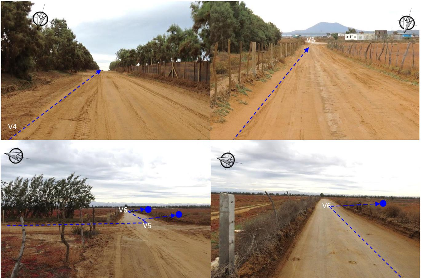
**Foto 28.** Fotografías que muestra la línea de la tubería del agua de rechazo (color azul) por el camino de terracería hasta llegar a los pozos de infiltración (círculos azules).
