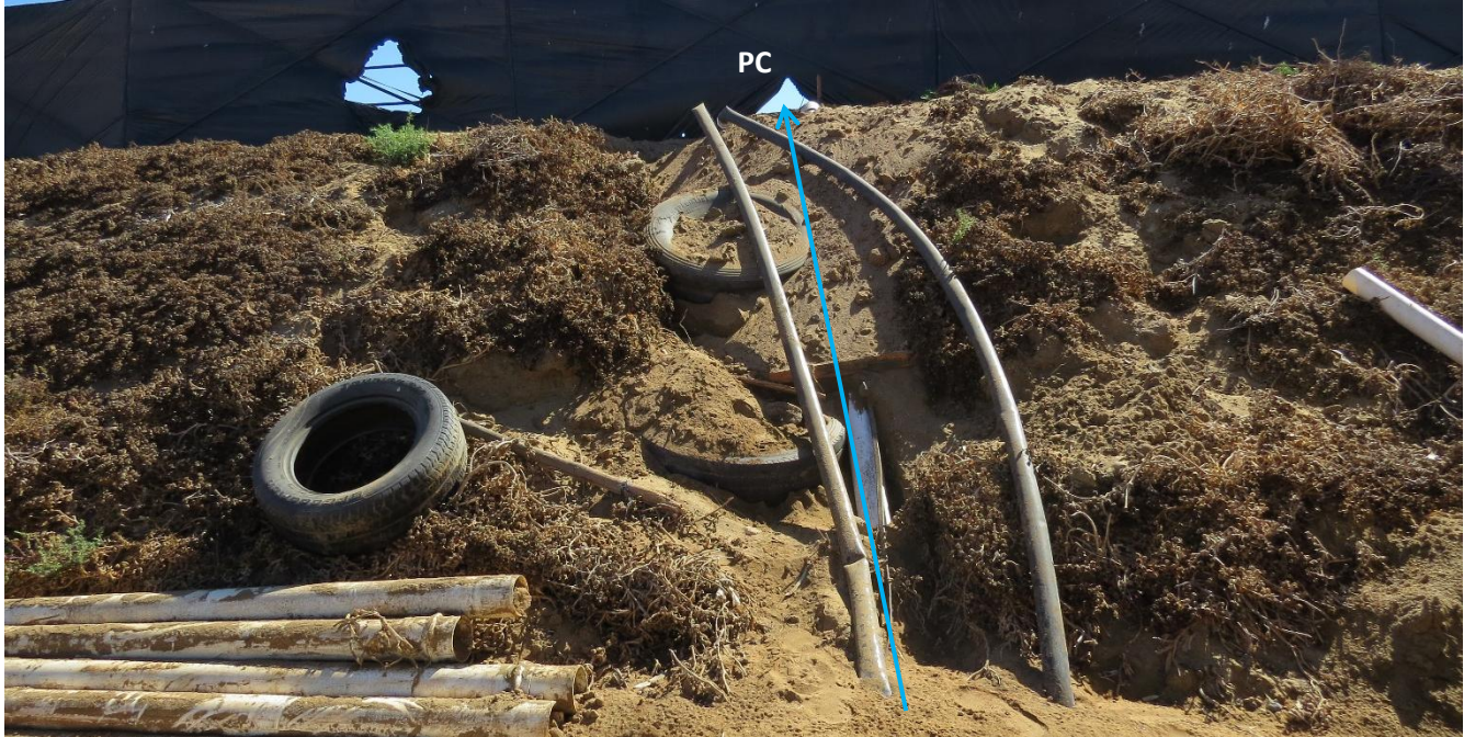
Foto 10. Punto de conexión (PC) con el reservorio de agua de pozo de Agroproduce El Pabellón HG
