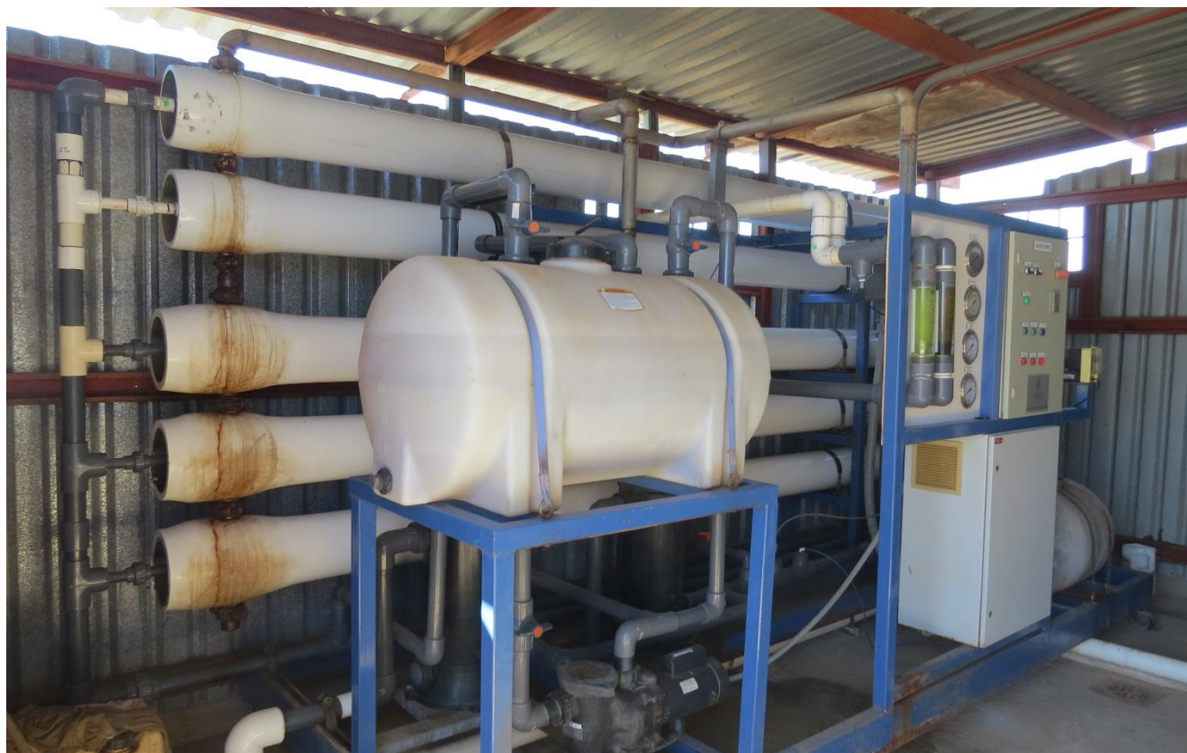
Foto 2. módulo de osmosis inversa instalado en el interior de la nave.
