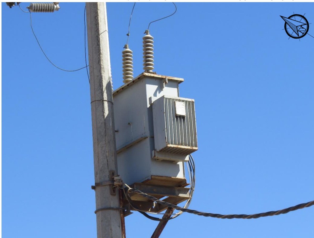
Foto 6. Subestación eléctrica de 75 KVA.
