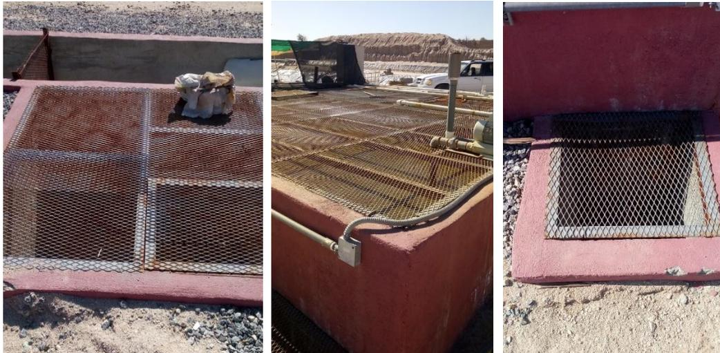
*Figura 6. Sistema de Flotación de Aire Disuelto (DAF).*
