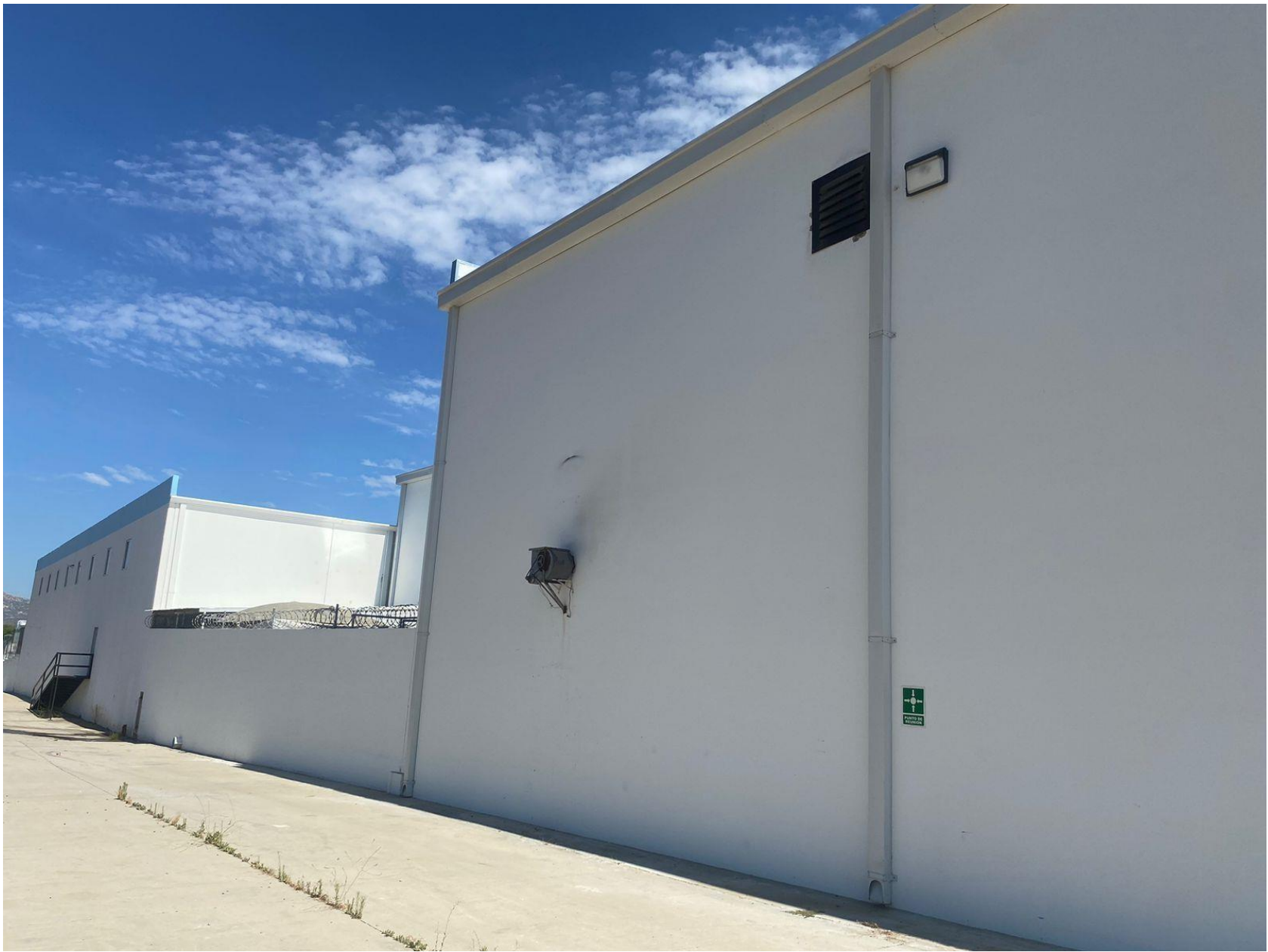
Fotografía 2. PARTE POSTERIOR DE LA NAVE MEXUS 2
