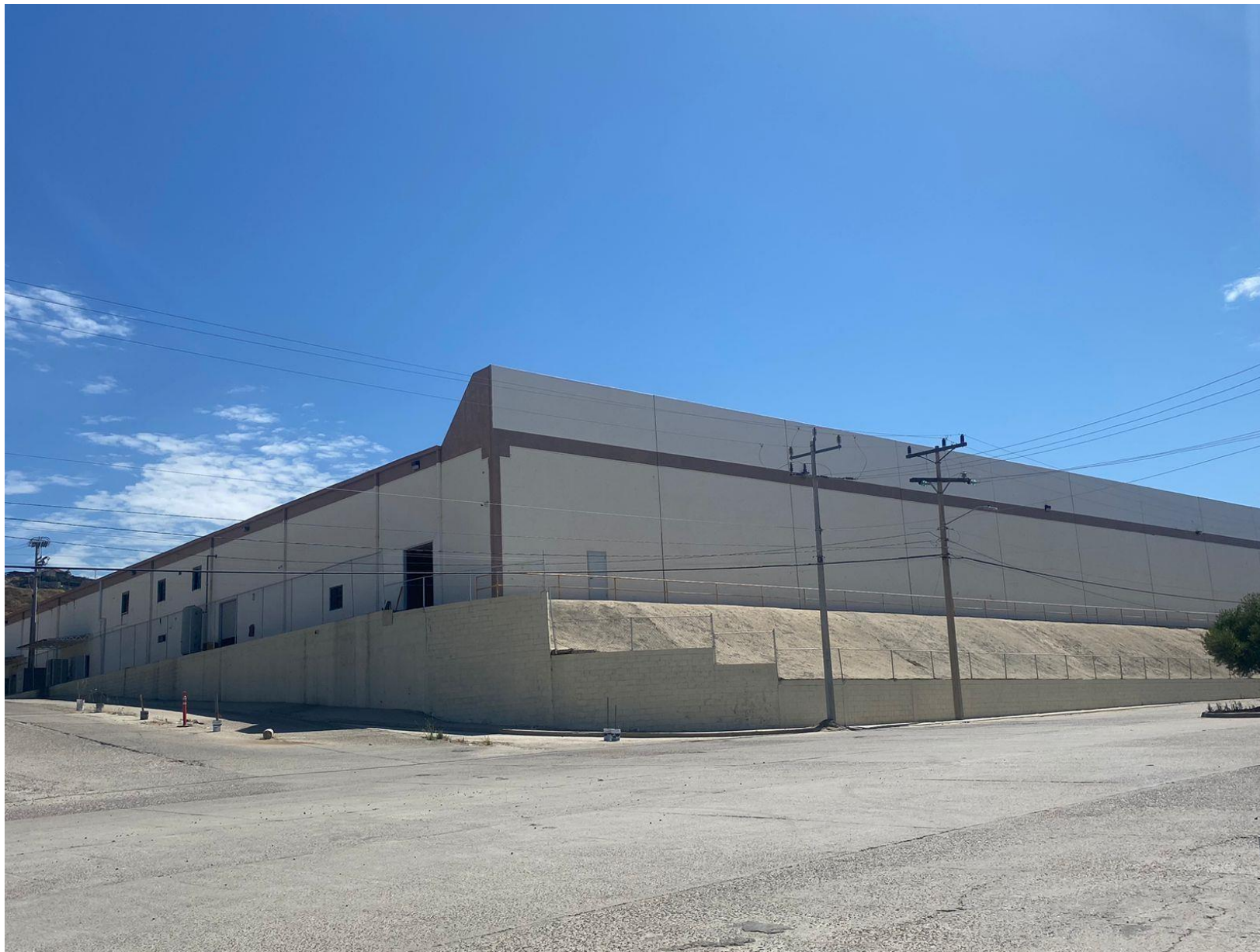
Fotografía 5. VISTA TOMADA EDIFICIOS FRENTE LADO DERECHO A MEXUS
