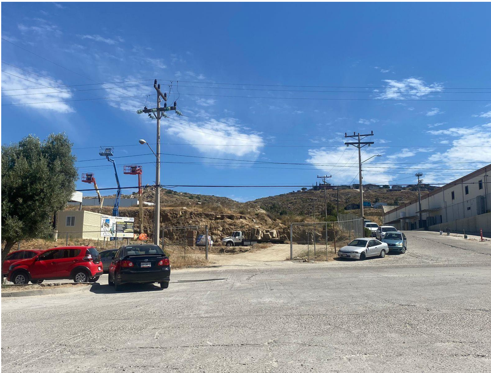
Fotografía 1. PARTE FRENTE DE LA PLANTA LADO IZQUIERDO
