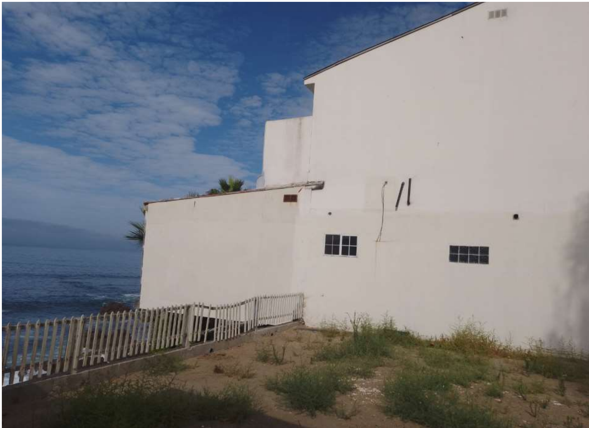
Fotografía 9. Interior de concesión No. DZF-421/91. Orientación Este-Oeste. Casa habitación existente del promovente.
