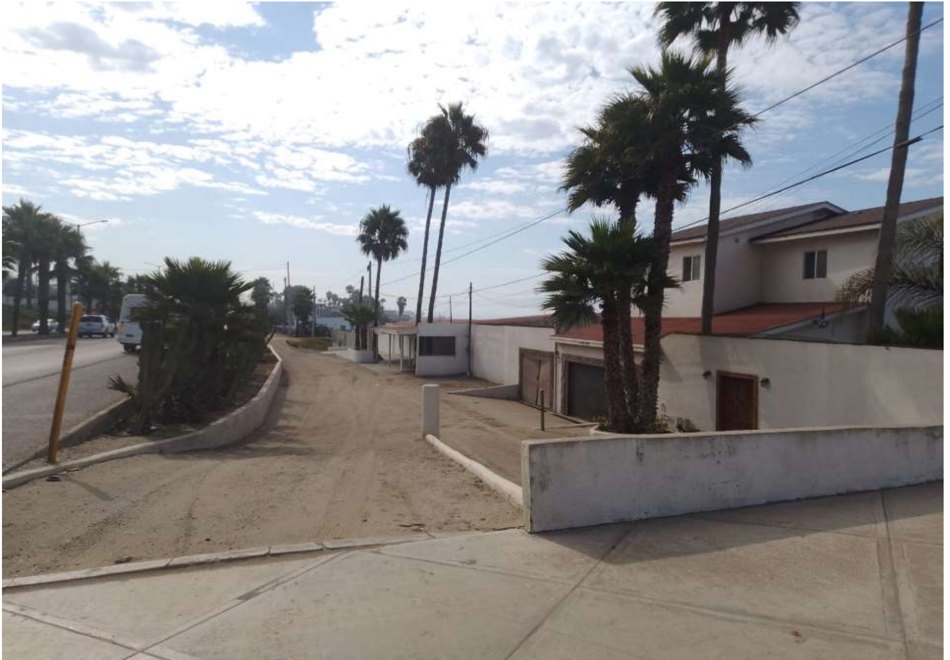
Fotografía 5. Exterior de concesión No. DZF-421/91. Orientación Oeste-Este. Al interior está la casa habitación existente.
