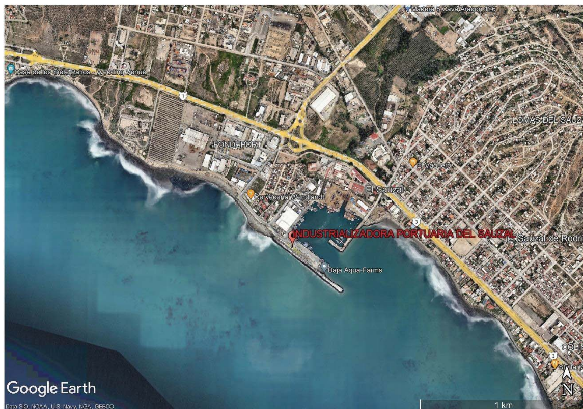
Figura I.1 Localización, rasgos fisiográficos e hidrológicos sobresalientes, el proyecto se localiza en zona litoral expuesta a oleaje de tormenta y procesos de erosión.
