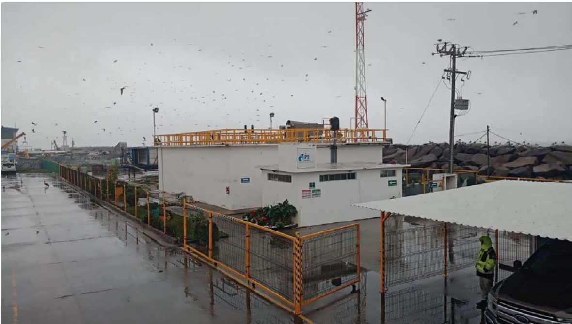
Foto No.1.- Foto tomada en punto 31^{\circ}53'36.56''\text{N} y 116^{\circ}42'20.76''\text{O} , vista en dirección SurEste, se observa las instalaciones IPS (delimitado por cerco amarillo).
