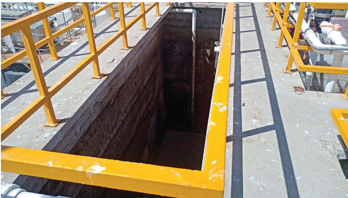
Foto No.11.- Foto tomada desde las pilas de tratamiento de la PTAR, vista de pila de concentración y de solidos.
