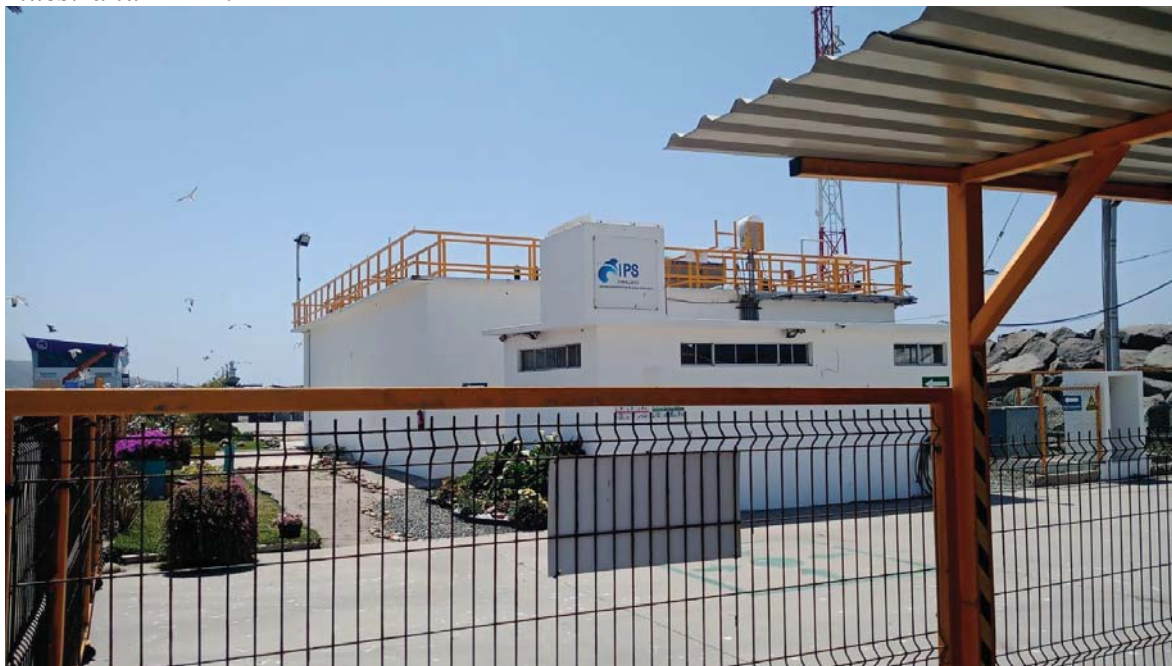
Fotografía II.3 Muestra los edificios de la PTAR existente, al frente se observa las oficinas, al fondo los tanques de concretos.
