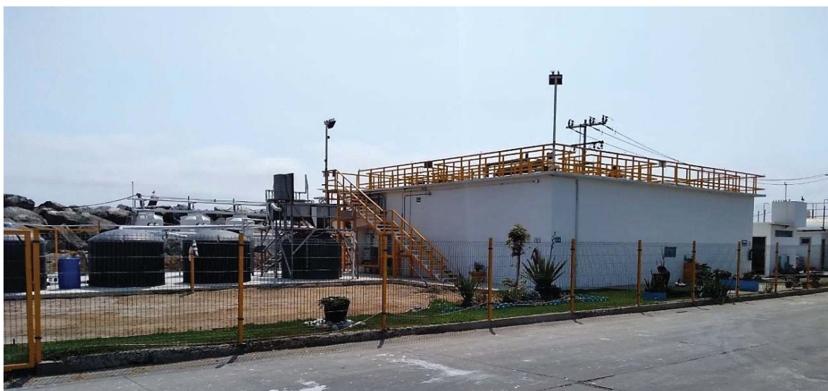
Fotografía II.2 Muestra margen izquierdo el Piso de tierra que está preparada para colocar cemento en la superficie parte Sur restante.
