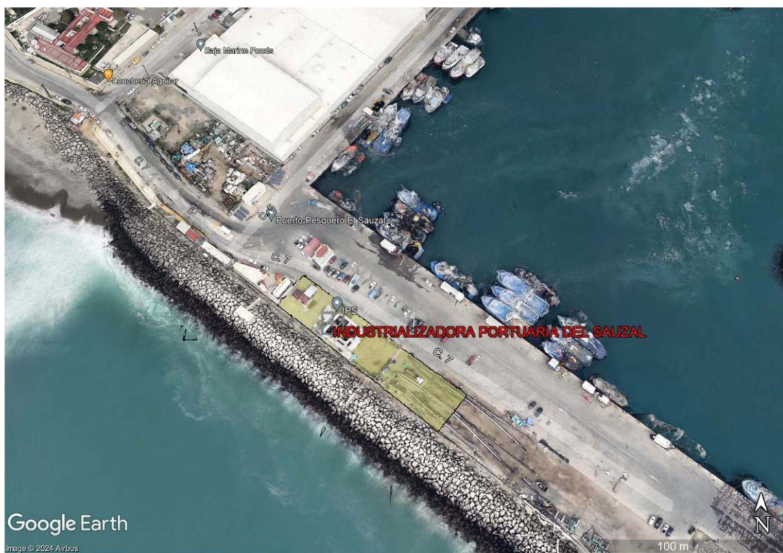
Figura II.2 Ubicación Física del Proyecto dentro del Muelle No. 1 del Recinto Portuario de El Sauzal.
