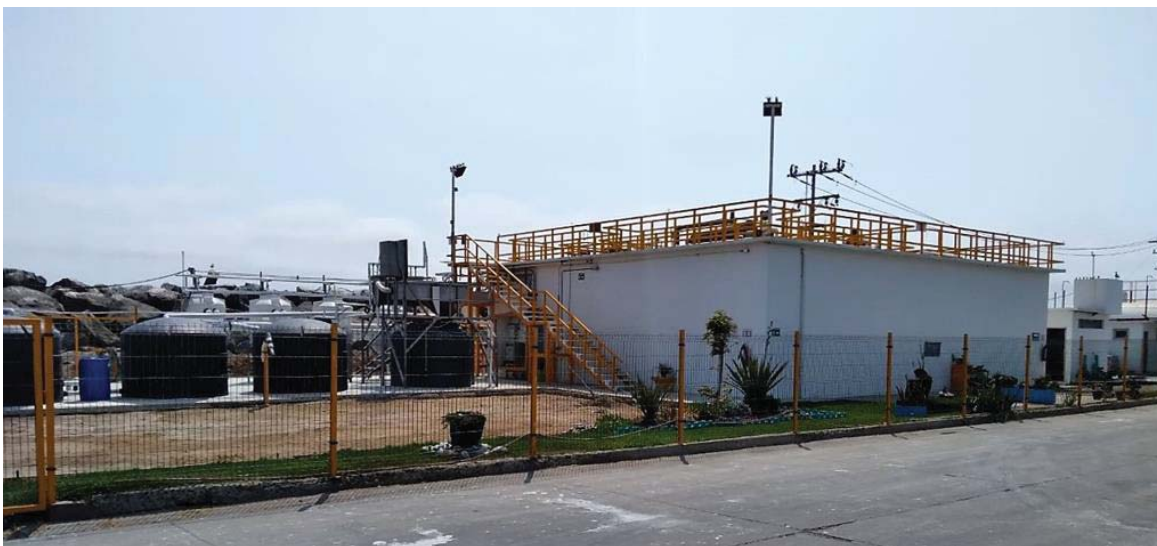
Fotografía II.1 Planta de Tratamiento de Aguas Residuales (PTAR) que se encuentra construida y operando.
